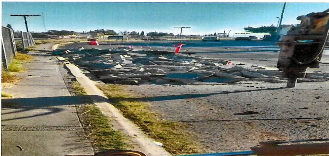
DEMOLICION Y APERTURA CAJON
