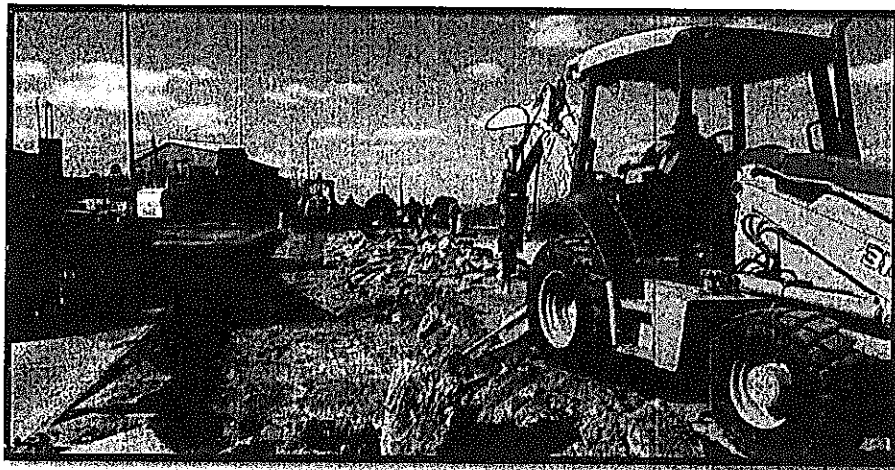
DEMOLICION Y APERTURA CAJON
