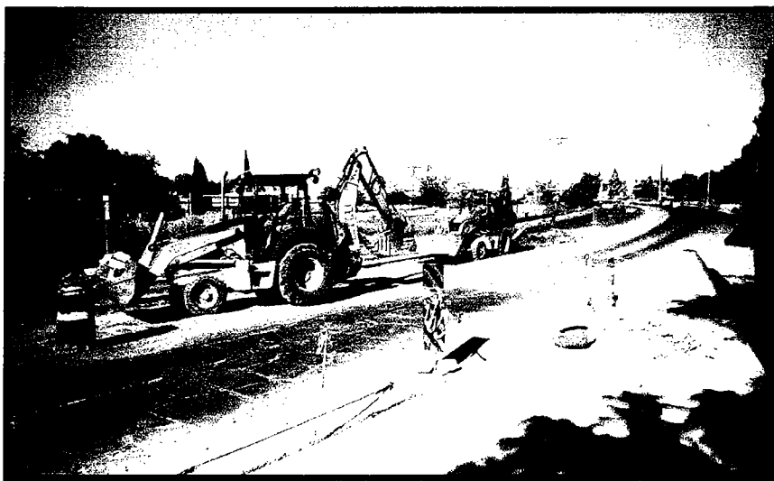
RETIRO DE MATERIALES PRODUCTO DE EXCAVACIONES Y DEMOLICION DE LOSA EXISTENTE
