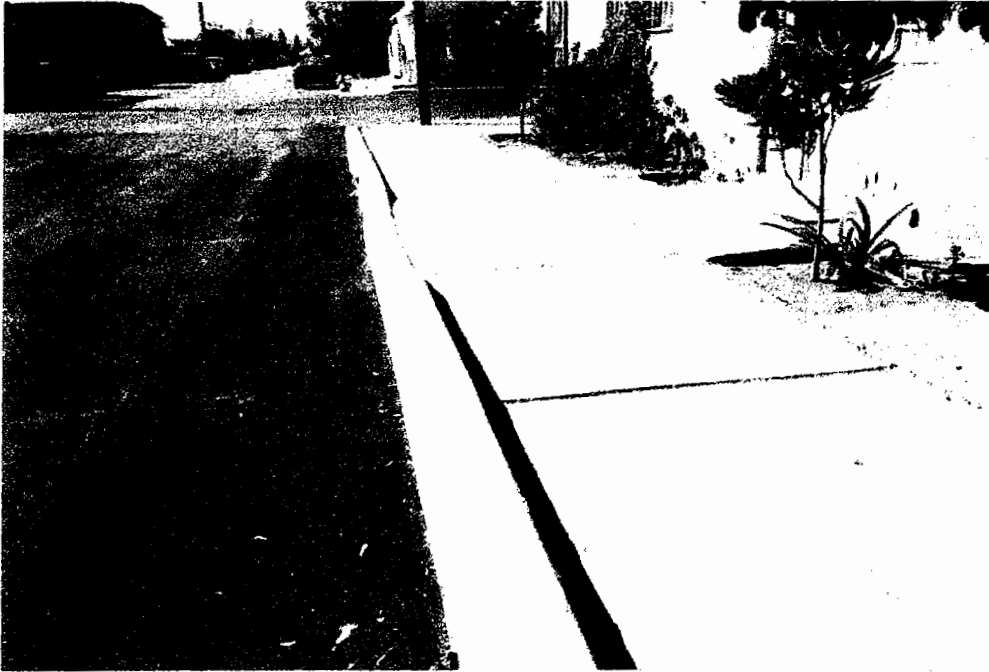
BANQUETAS Y GUARNICION
