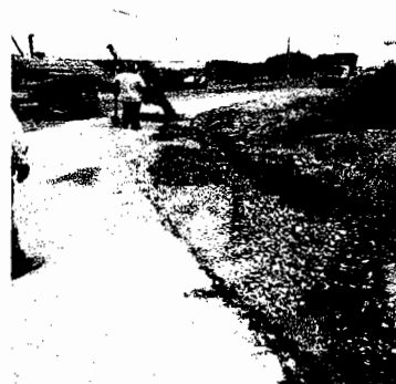
FORMACIÓN Y COMPACTACIÓN DE CAPA DE BASE HIDRÁULICA DE 20 CMS DE ESPESOR, PROVENIENTE DEL MATERIAL DE BANCO QUE ELIJA EL CONTRATISTA COMPACTADA AL 95 %.
