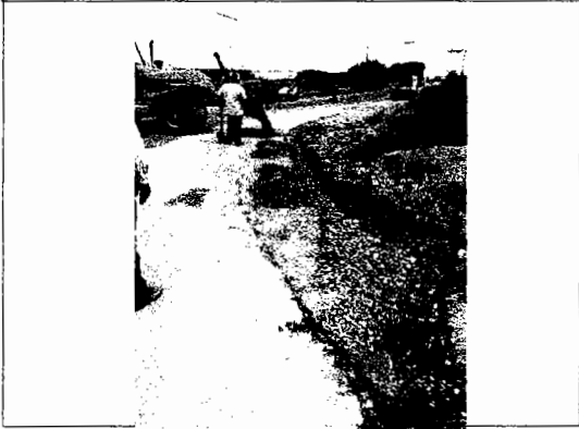
COMPACTACIÓN DEL TERRENO NATURAL EN ÁREA DE DESPLANTE DE TERRAPLENES.
