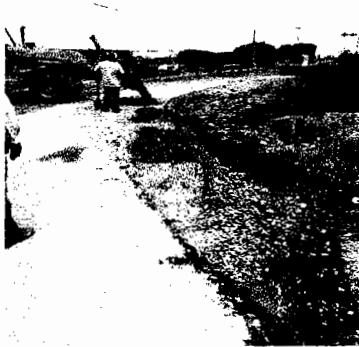
COMPACTACIÓN DEL TERRENO NATURAL EN ÁREA DE DESPLANTE DE TERRAPLENES.
