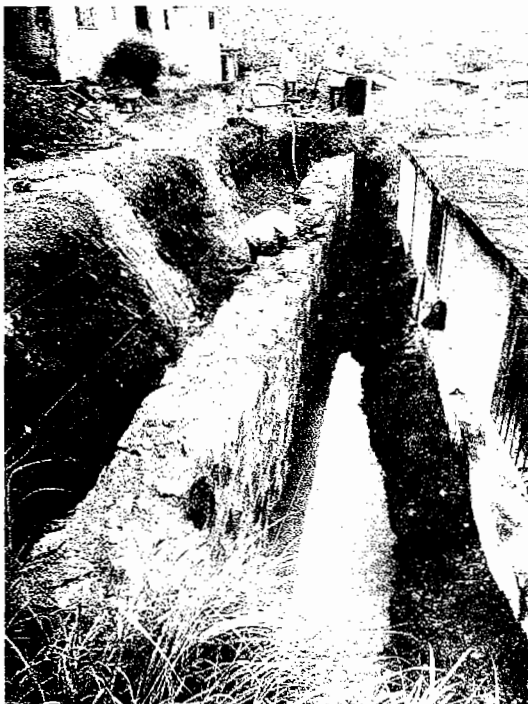
Trazo, Muro y zanja inundada
