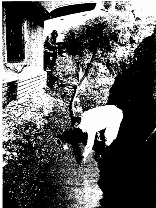
Bombeo de Agua en Zanja Inundada
