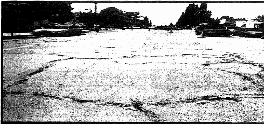
CALAFATEO EN CALLE 4A ENTRE PASEO SIMON BOLIVAR Y AV. 20 DE NOVIEMBRE
