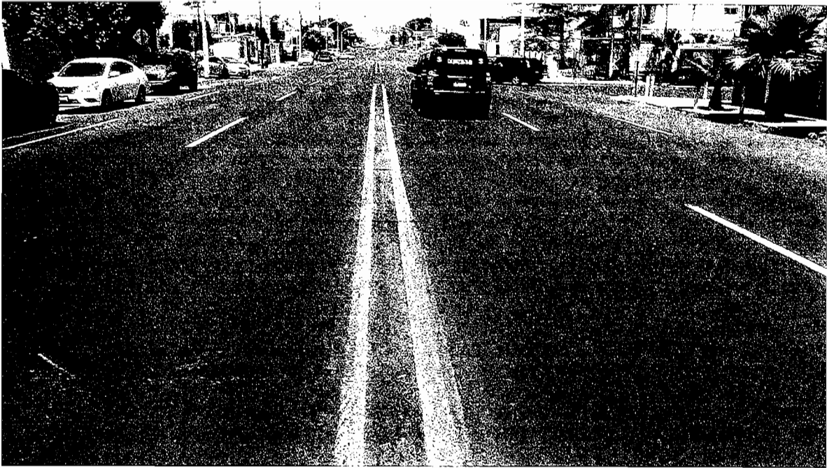
AVE. DE LAS AMERICAS Y C. RIO DE JANEIRO. VISTA AL ESTE.
