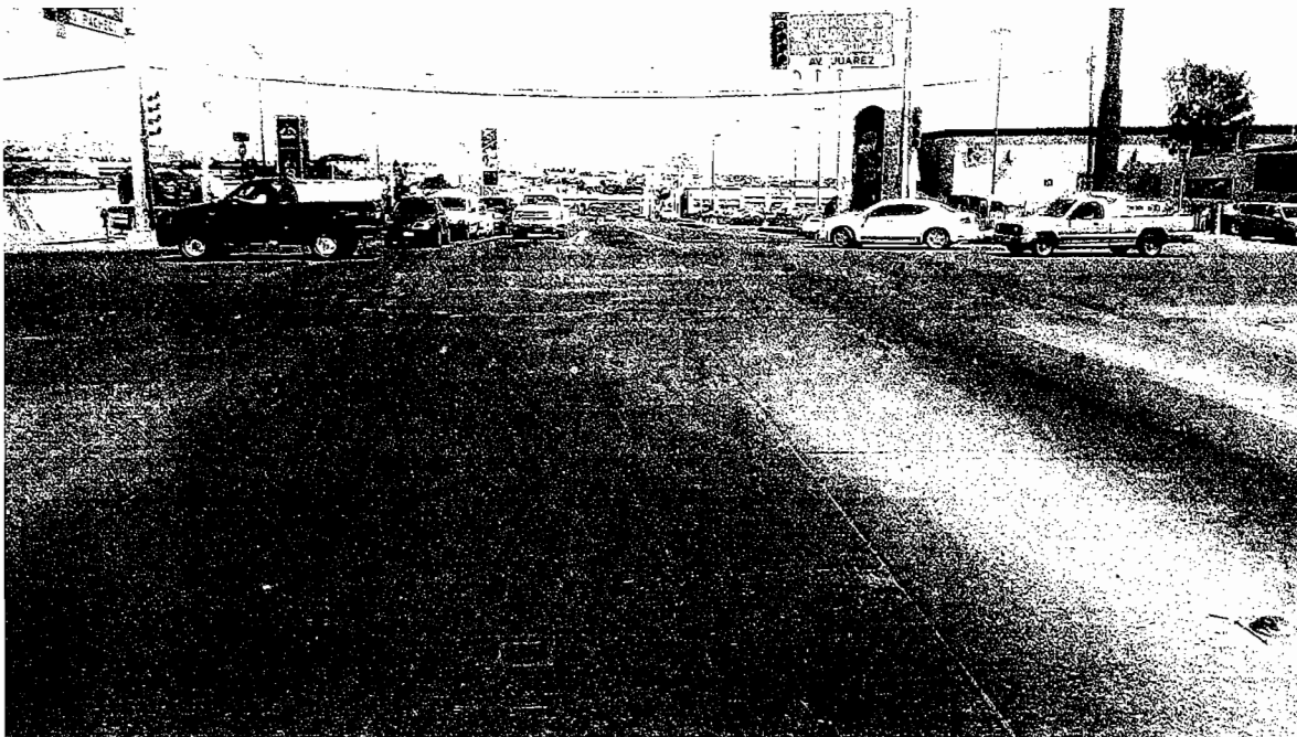
AVE. C. PACHECO VISTA HACIA NORTE DE AVE. JUAREZ
