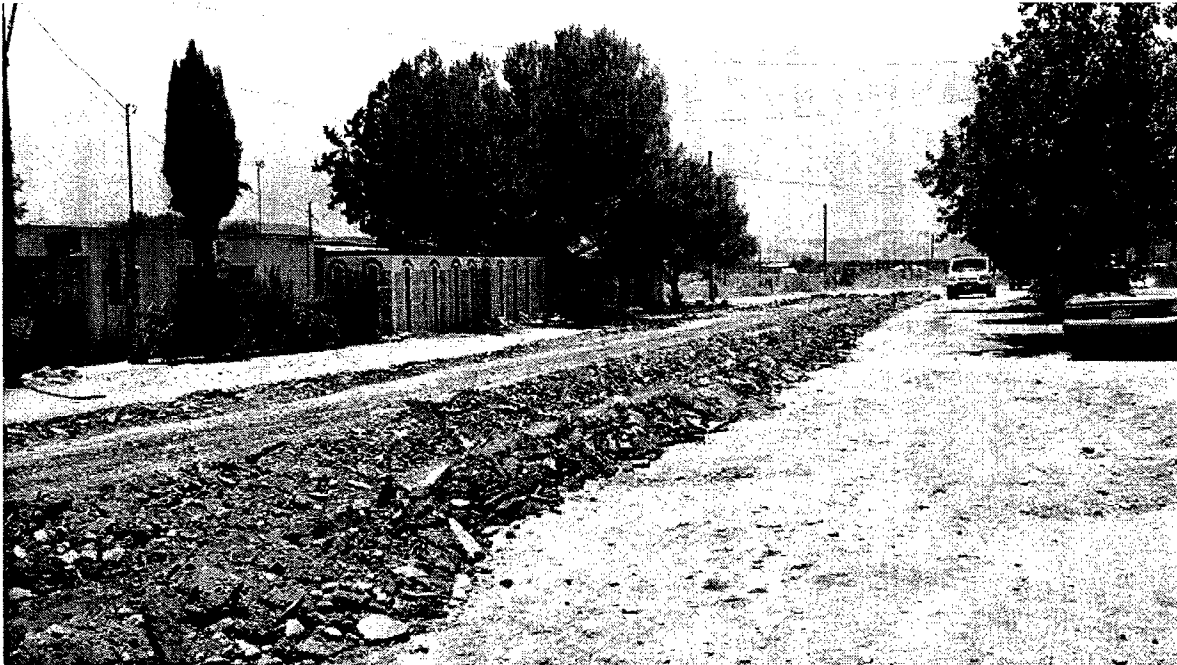
DEMOLICION DE CARPETA ASFALTICA
