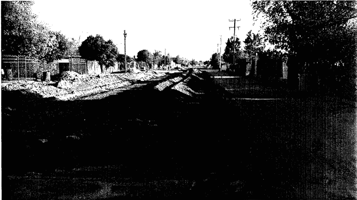
SUMINISTRO DE BASE HIDRAULICA
