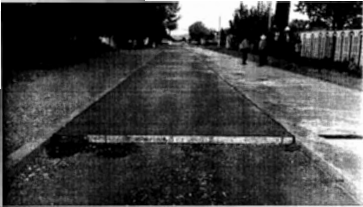
COLADO DE CARPETA HIDRAULICA
