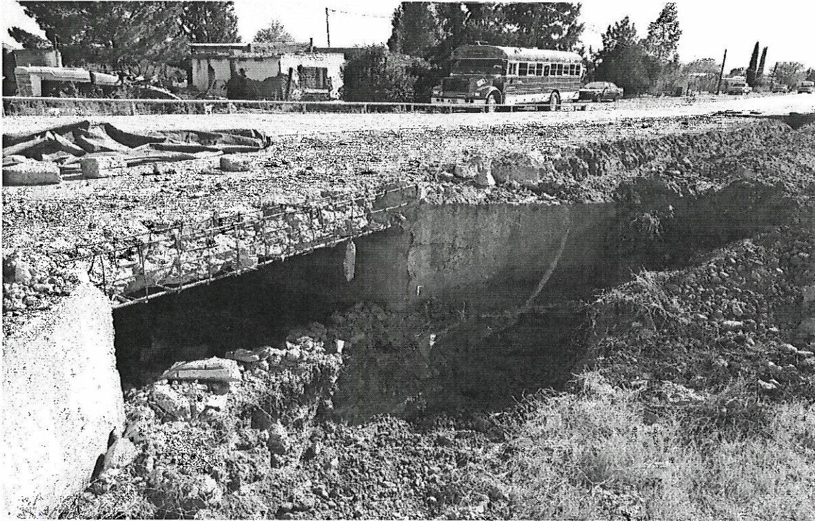
DEMOLICION EN OBRA DE DRENAJE
