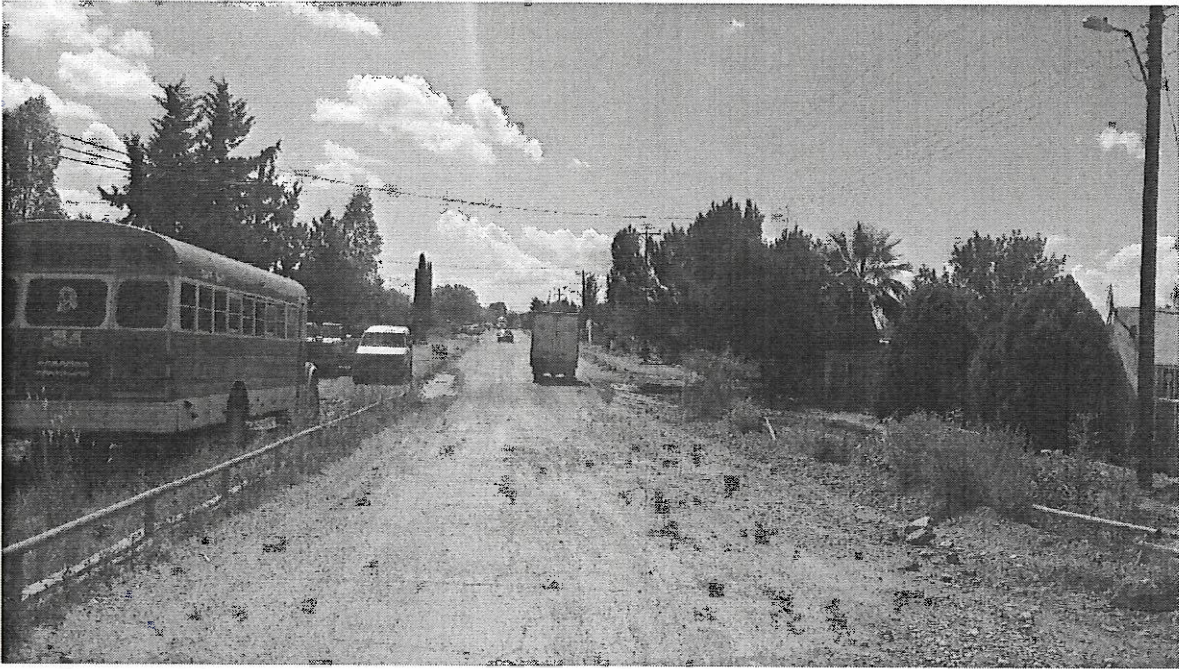
ARREGLO DE BARANDAL Y RETIRO
