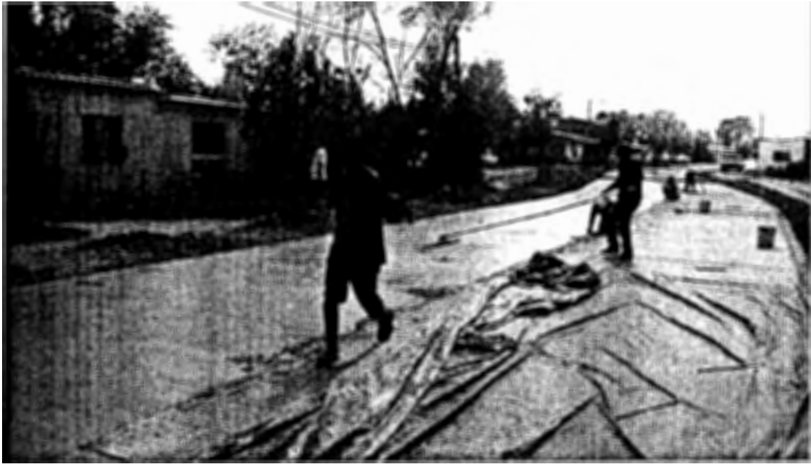
SUMINISTRO Y COLOCACION DE CONCRETO HIDRAULICO
