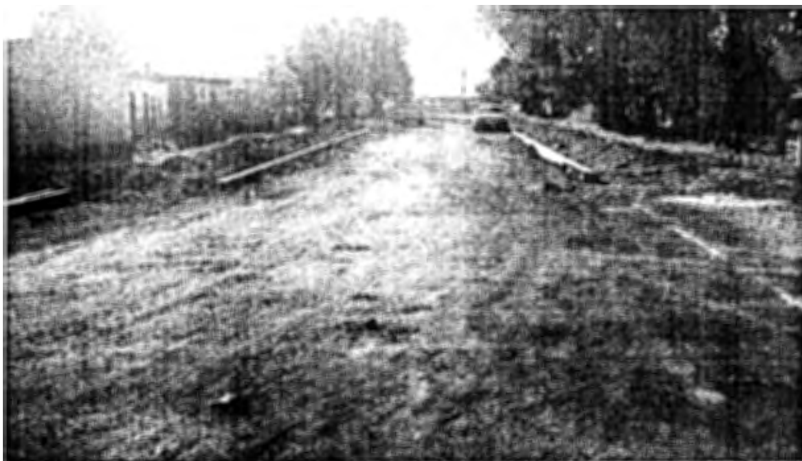
SUMINISTRO Y COLOCACION DE DENTELLON
