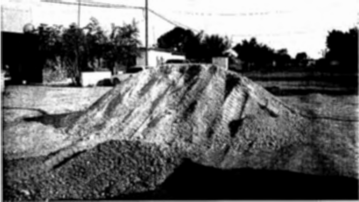
MATERIAL TRITURADO PARA MEJORAMIENTO DE BASE
