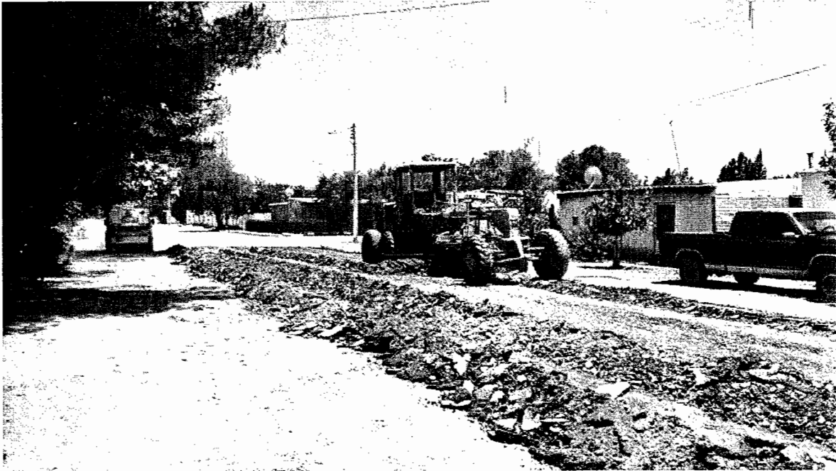
DEMOLICION DE CARPETA ASFALTICA
