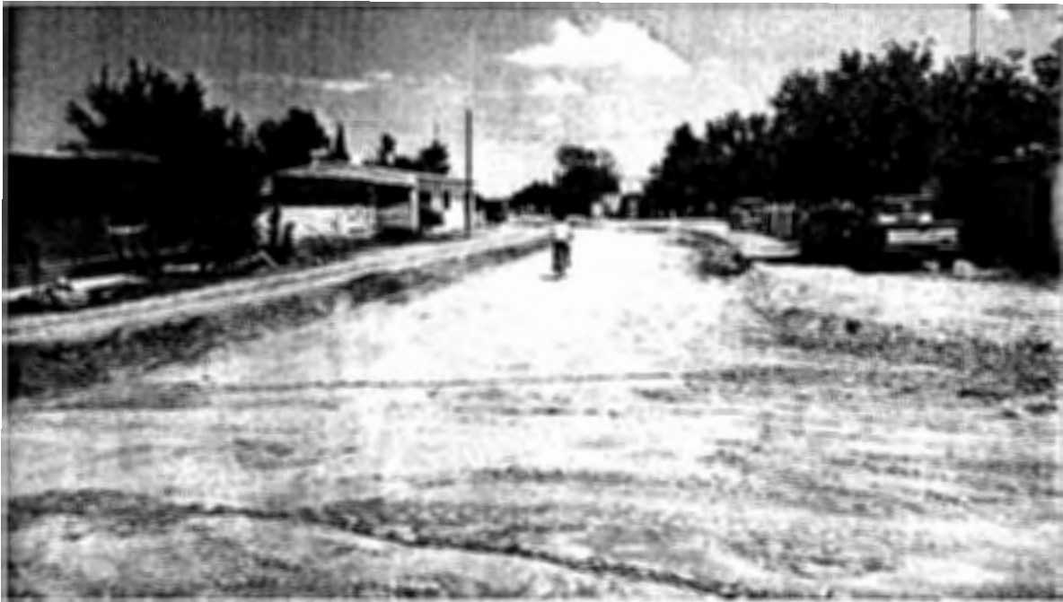
COMPACTACION DE TERRENO NATURAL
