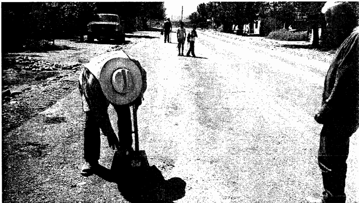
PRUEBAS DE COMPACTACION DE LA BASE
