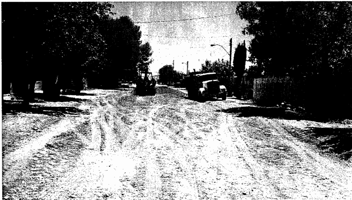
EXCAVACIONES Y RETIRO DE MATERIAL
