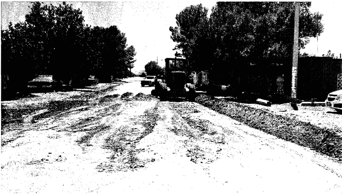
NIVELACION TE TERRENO NATURAL
