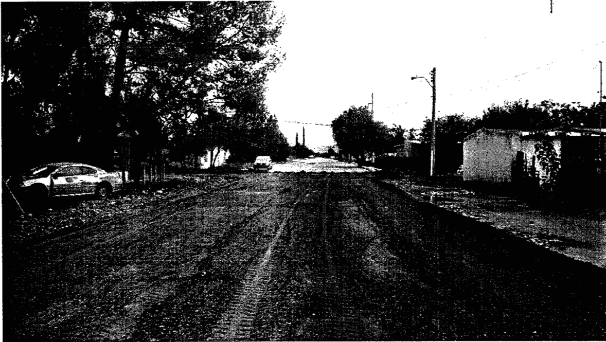
TRATADO Y TENDIDO DE MATERIAL PARA BASE
