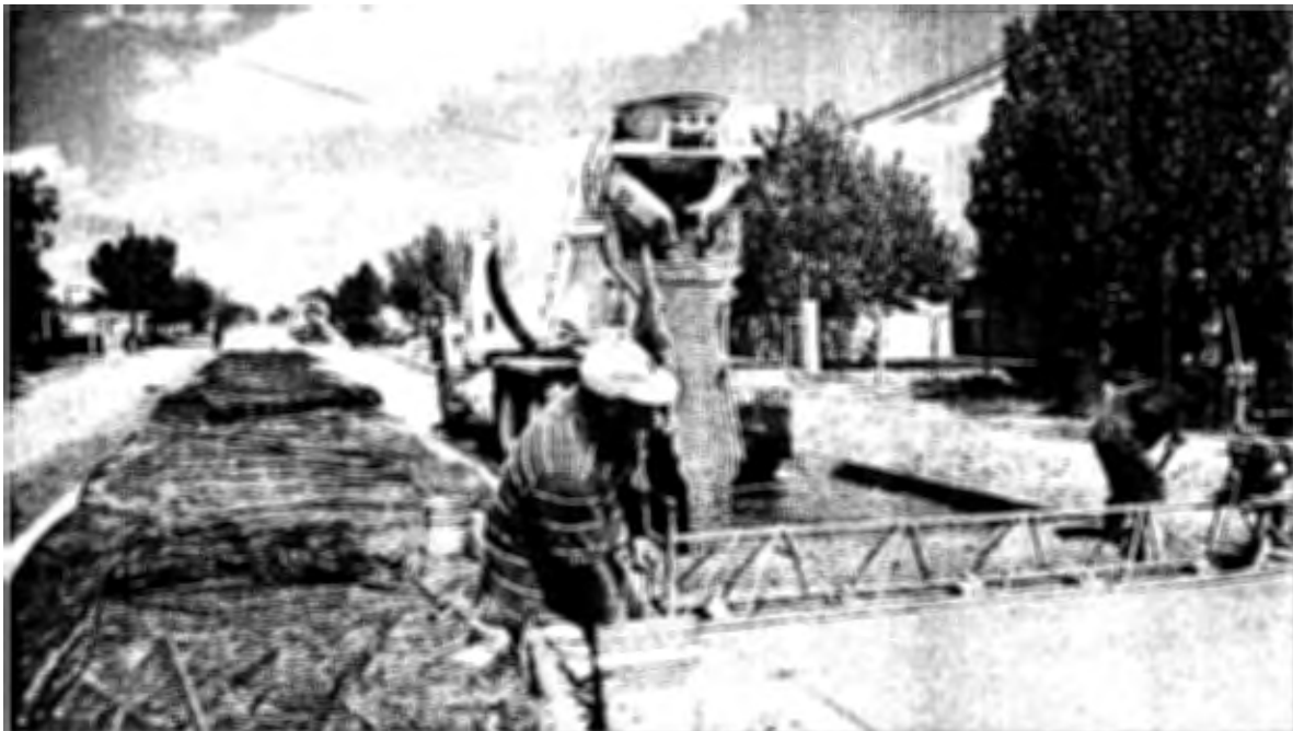
SUMINISTRO Y COLOCACION DE CONCRETO HIDRAULICO
