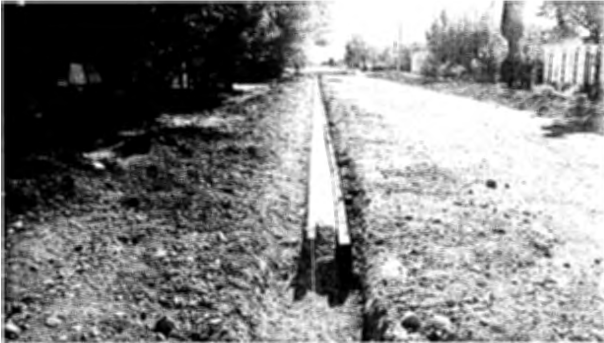
SUMINISTRO Y COLOCACION DE DENTELLON
