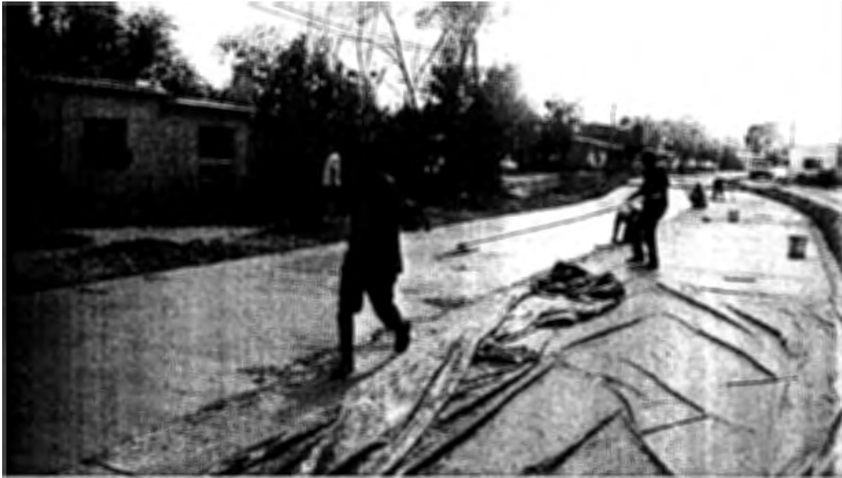
SUMINISTRO Y COLOCACION DE CONCRETO HIDRAULICO
