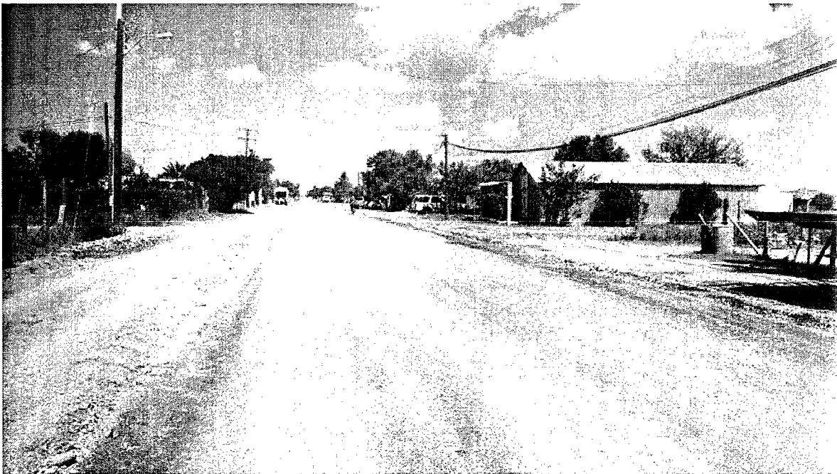
SUMINISTRO Y COLOCACION DE RIEGO DE IMPREGNACION
