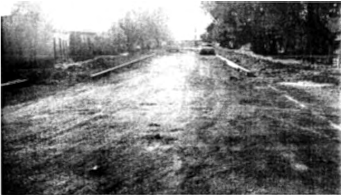
SUMINISTRO Y COLOCACION DE DENTELLON
