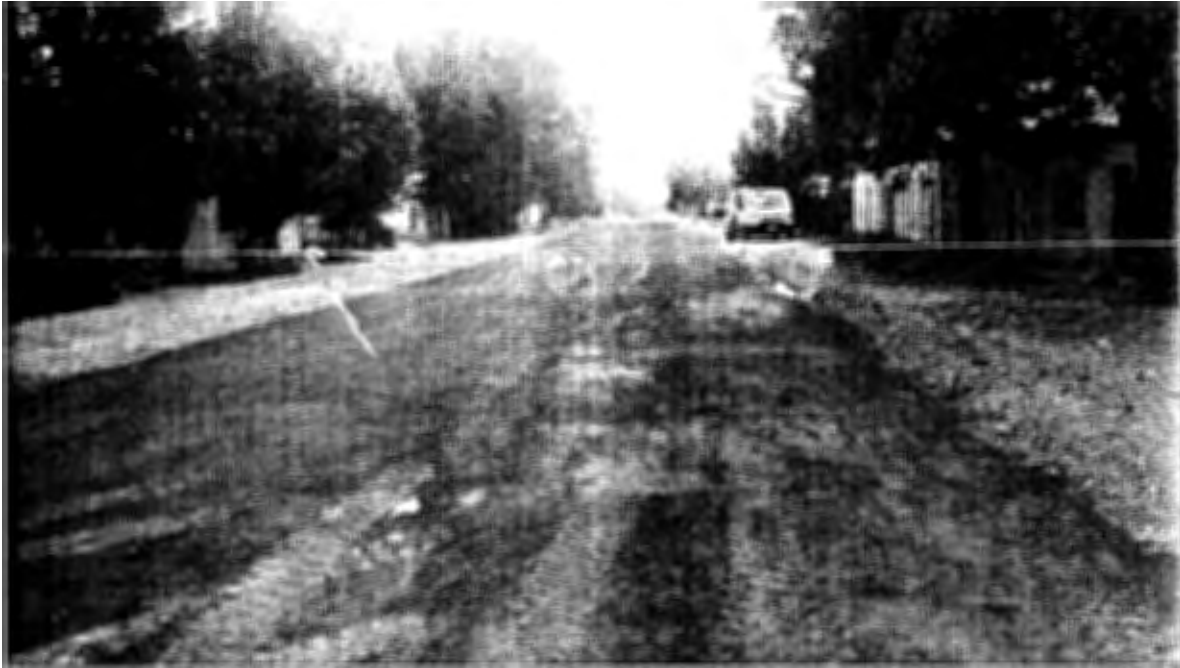
SUMINISTRO Y COLOCACION DE RIEGO DE IMPREGNACION
