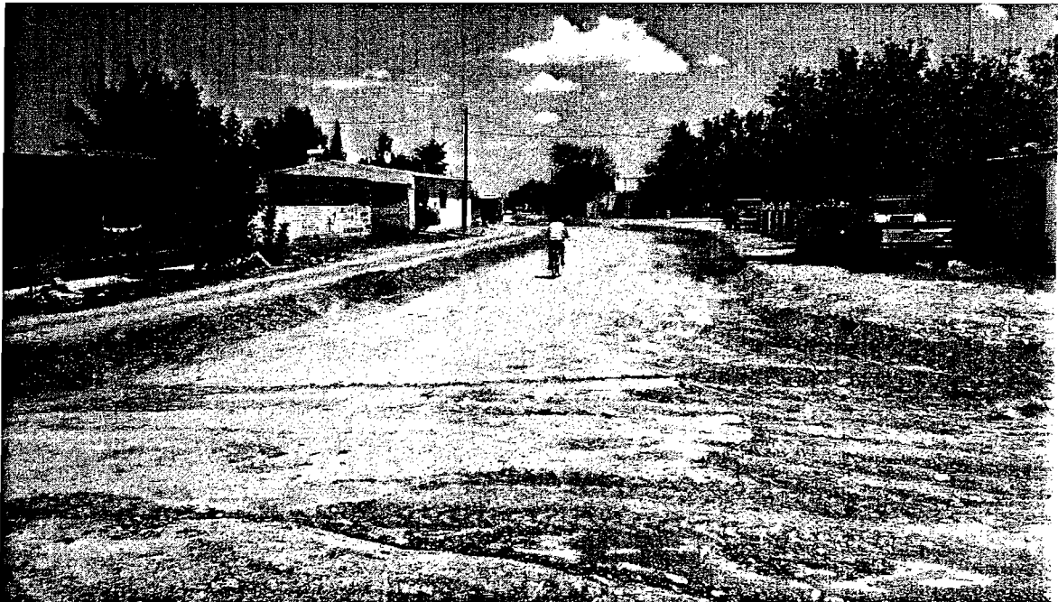
CORTES DE MATERIAL PARA COLOCACION DE BASE
