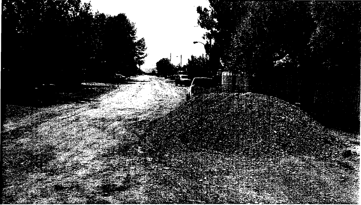
ACARREO DE MATERIAL PARA BASE
