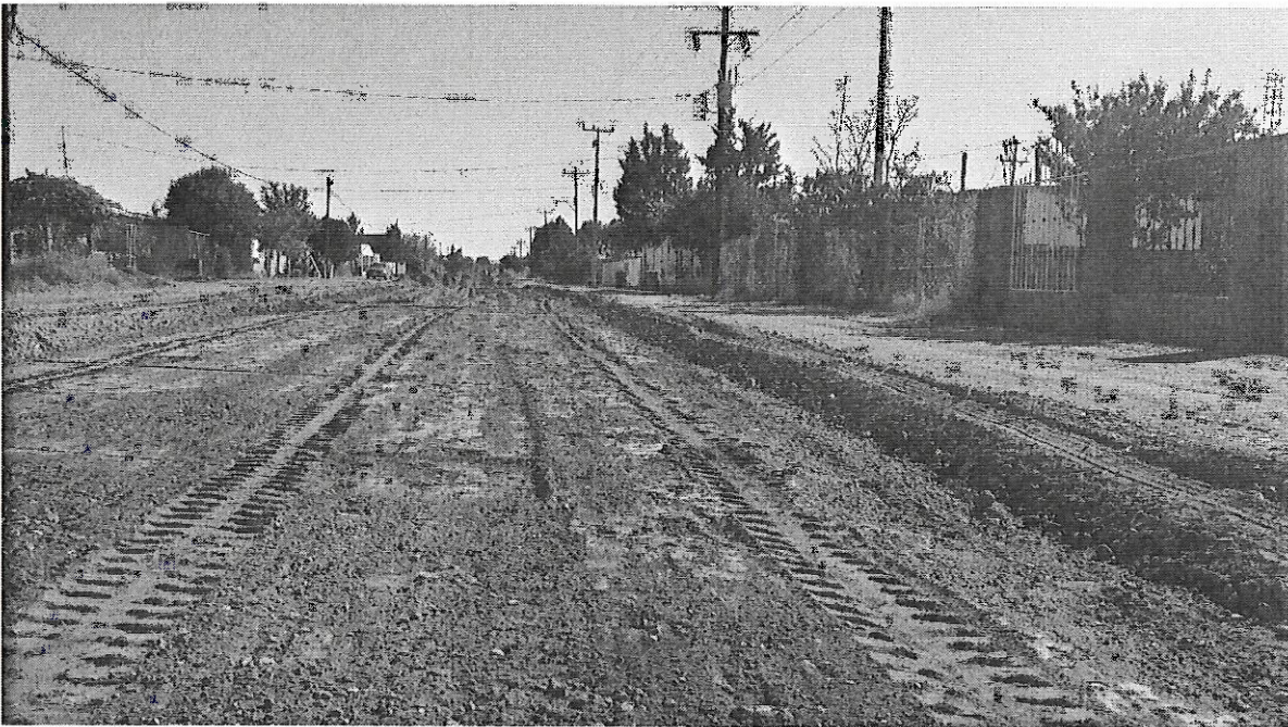
EXCAVACION EN CORTES
