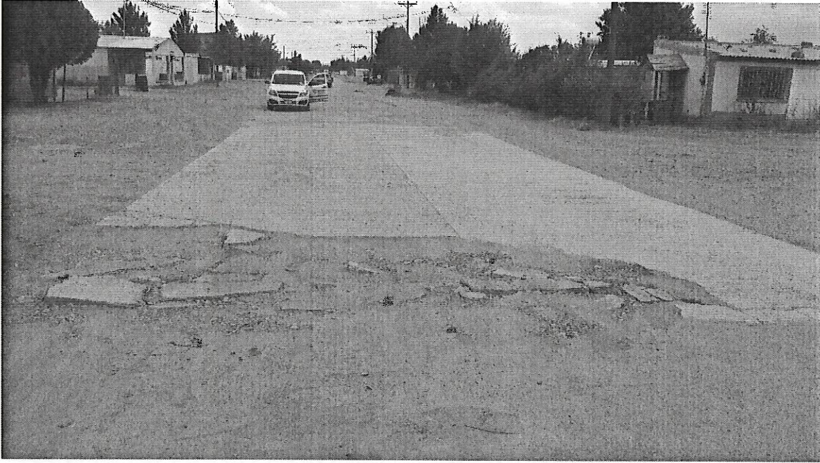
DEMOLICION DE CARPETA
