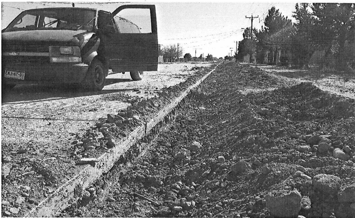
EXCAVACION PARA DENTELLON
