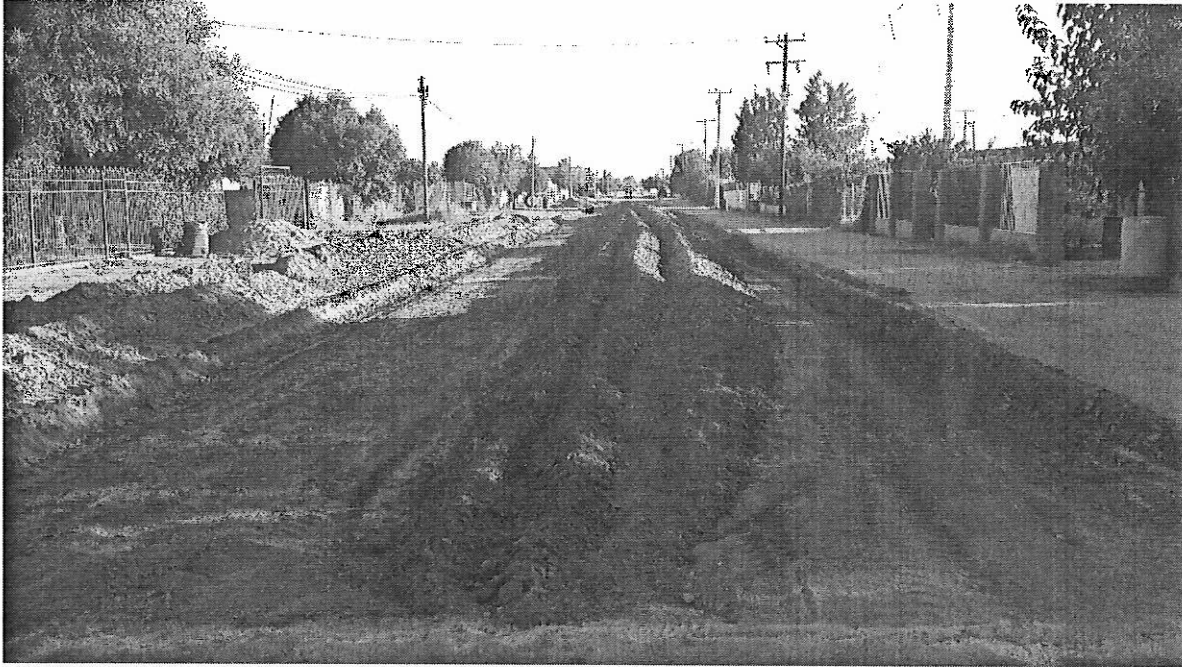
SUMINISTRO DE BASE HIDRAULICA
