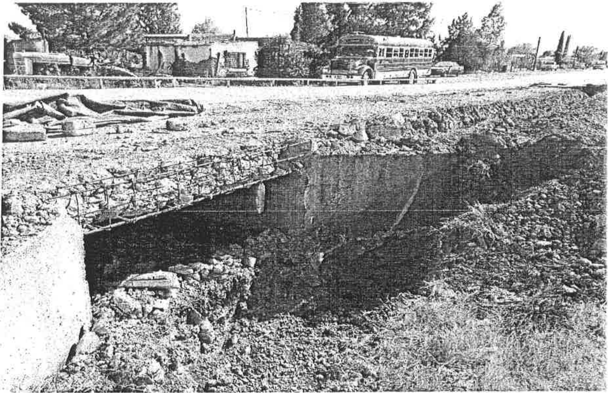
DEMOLICION EN OBRA DE DRENAJE
