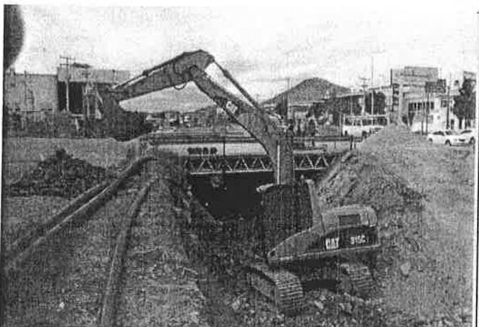
EXCAVACIÓN PARA ALOJAR FILTRO
