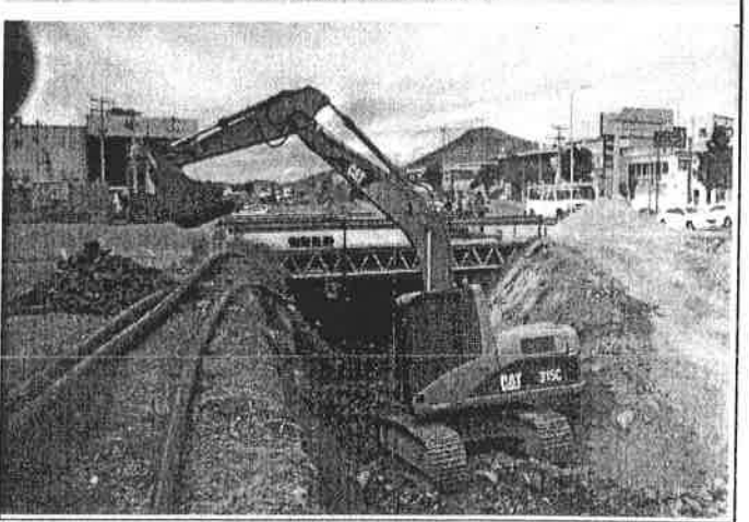
EXCAVACIÓN PARA ALJIBE FILTRO
