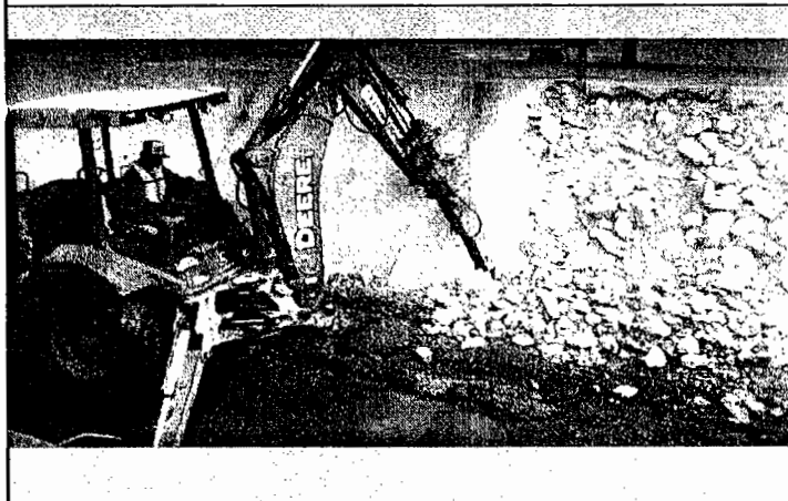
Demolición de Canal
