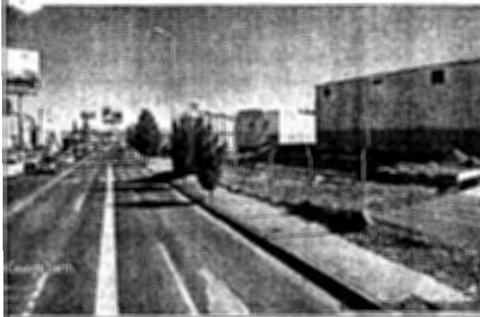
Foto. Av. La Cantera después de la canalización
