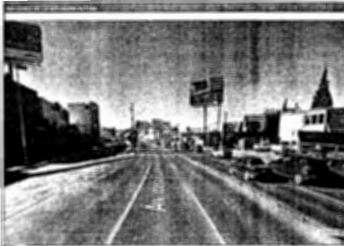
Foto. Av. La Cantera antes de la canalización
