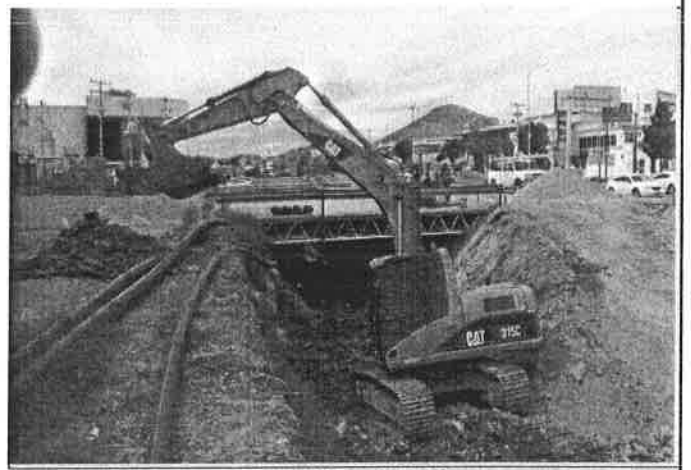
EXCAVACIÓN PARA ALJIBE FILTRO
