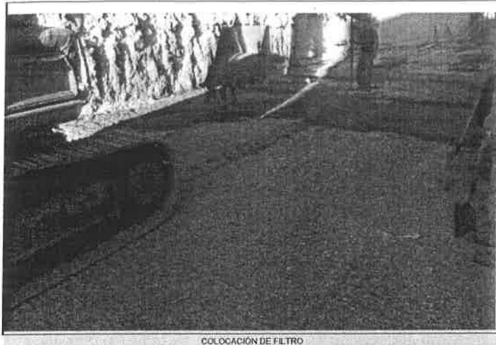
COLOCACIÓN DE FILTRO
