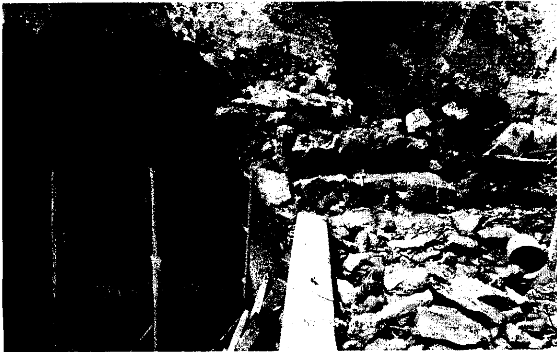
DEMOLICION DE MAMPOSTERIA
