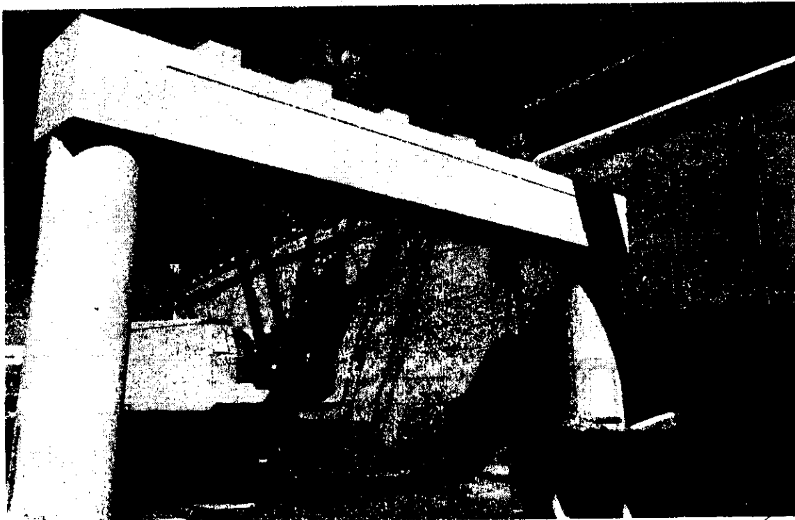
CONCRETO EN CABEZAL
