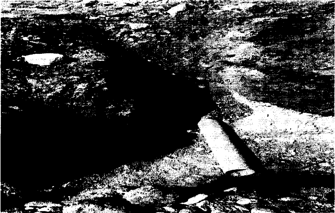
ZANJA PARA TUBERIAS
