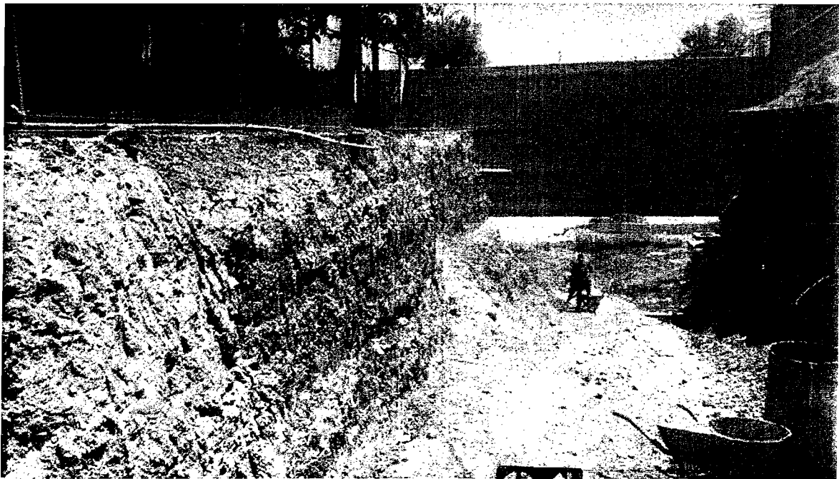
EXCAVACION EN MATERIAL "B" EN TALUD
