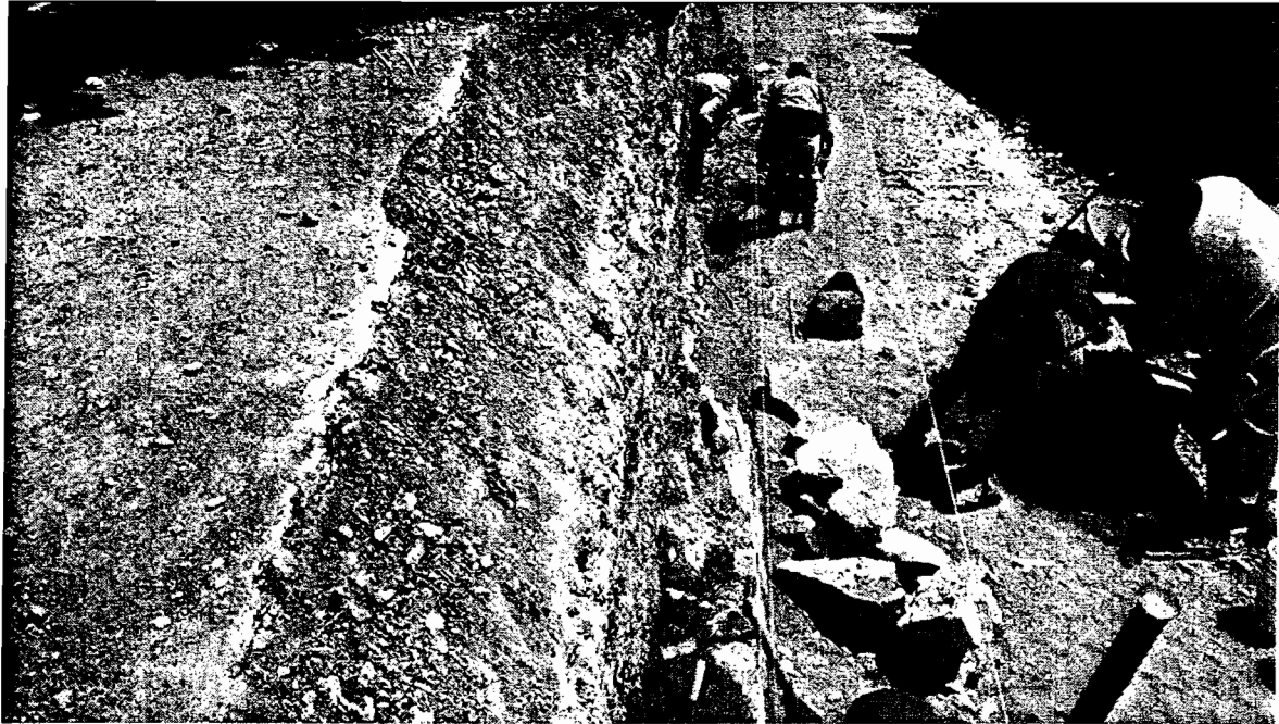
CONSTRUCCION DE ZAPATA A BASE DE MAMPOSTERIA
