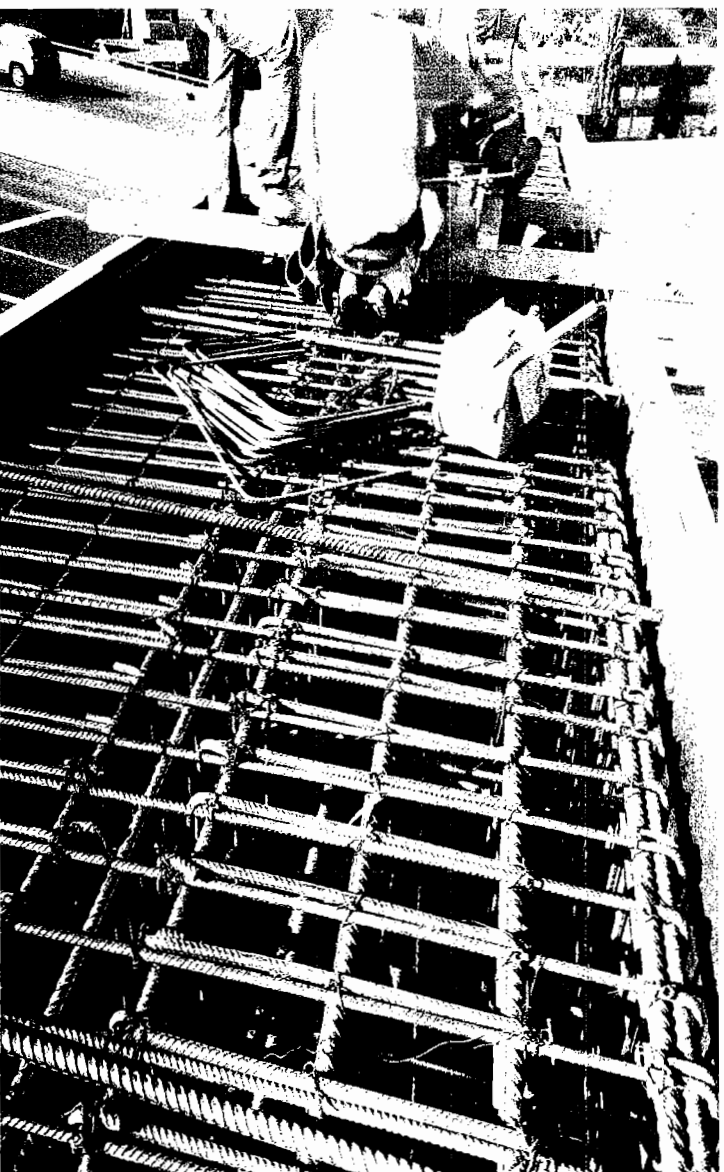
ACERO DE REFUERZO
