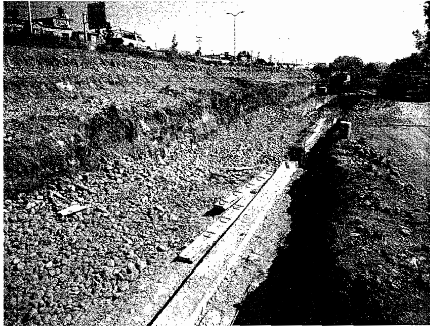
FORMACION DE PIEDRAPLEN EN RAMPA DE SALIDA
