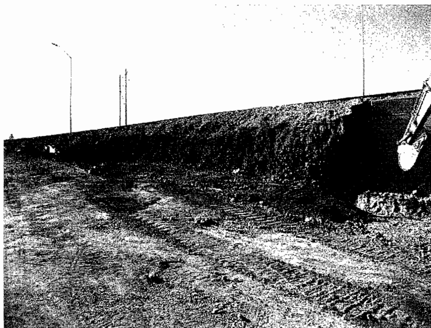
EXCAVACION EN CORTE EN RAMPA
