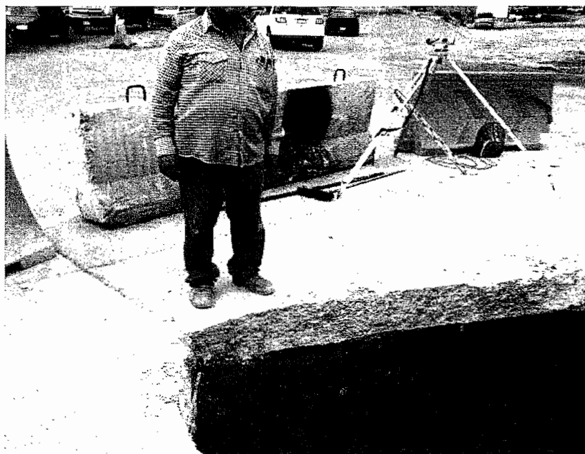
DEMOLICION DE CONCRETO HIDRAULICO
