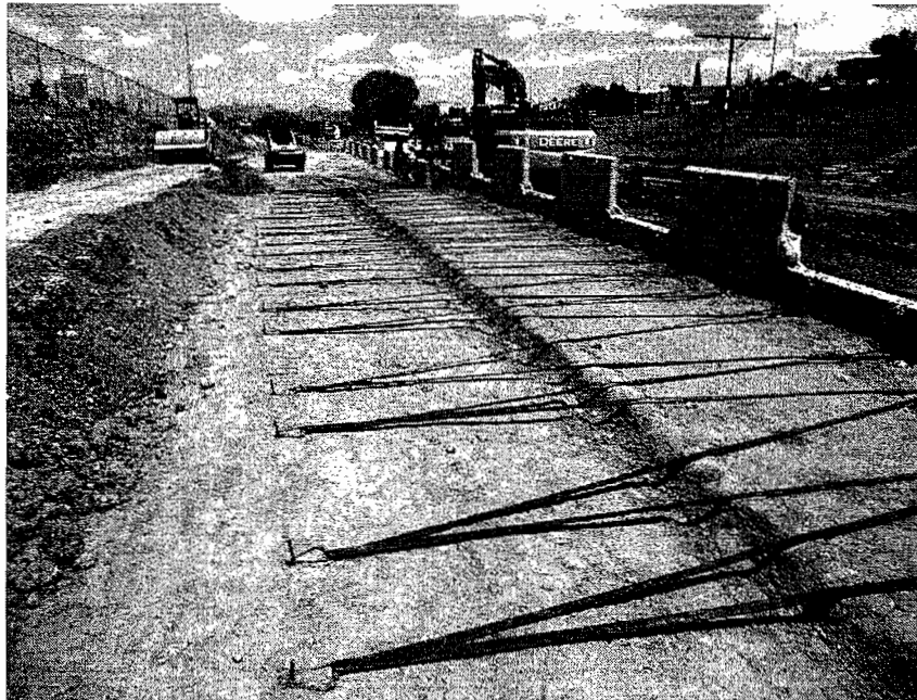
INSTALACION DE BANDAS PARA MUROS MECANICAMENTE ESTABILIZADOS
