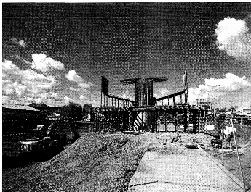
BANQUETA A DEMOLER
