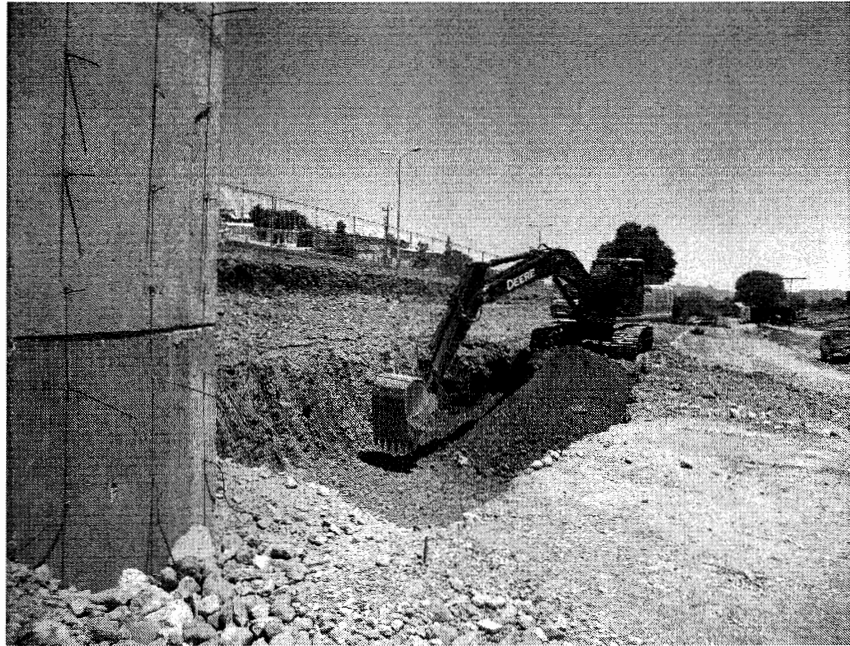
EXCAVACION EN RAMPA DE SALIDA
