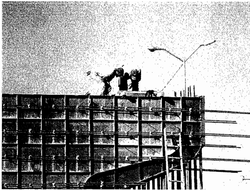
CIMBRANDO BANCOS PARA SU COLADO
