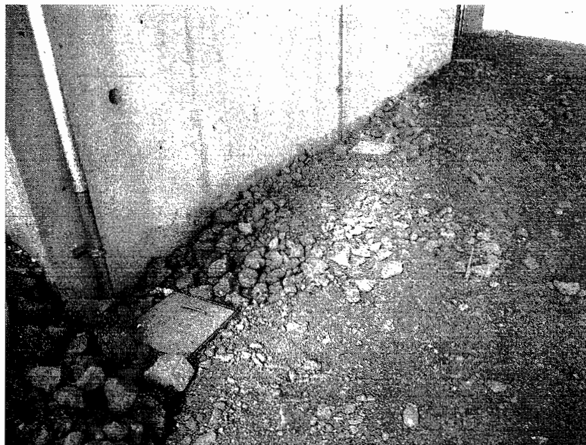
INSTALACION DE REGISTROS DE CONCRETO DE 40 X 40 X 40
