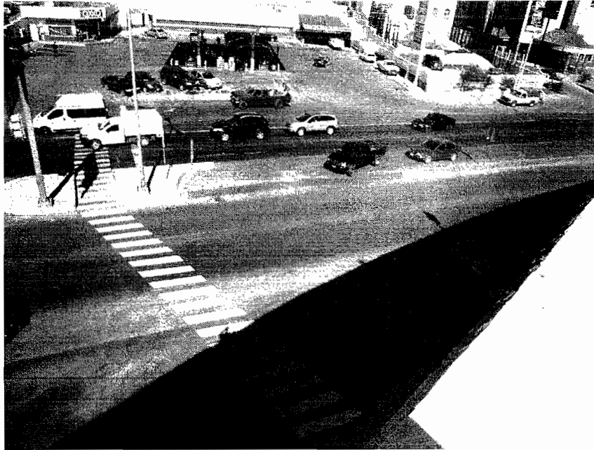
DEMOLICION DE GUARNICION PARA CONSTRUIR RETORNO
