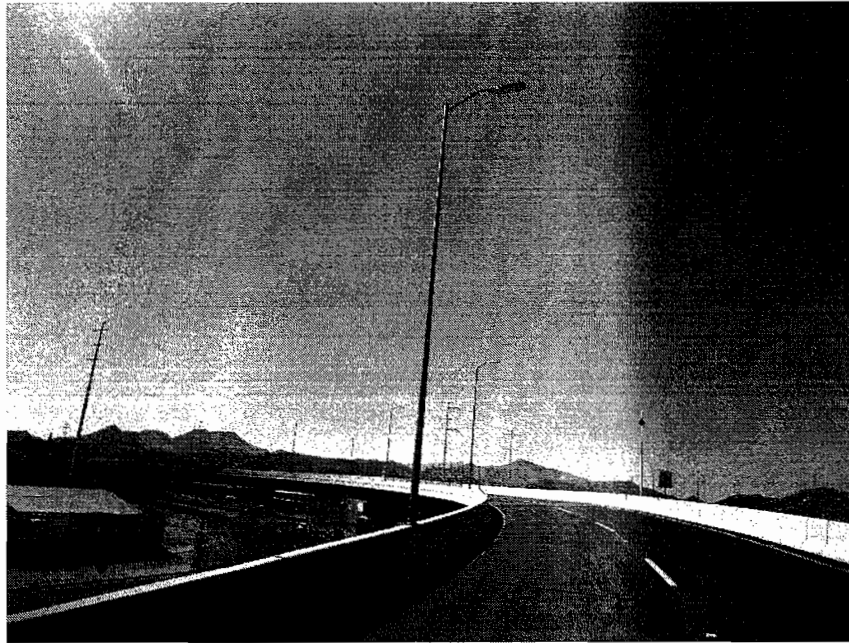
INSTALACION DE POSTES CONICOS DE 9 M DE ALTO
