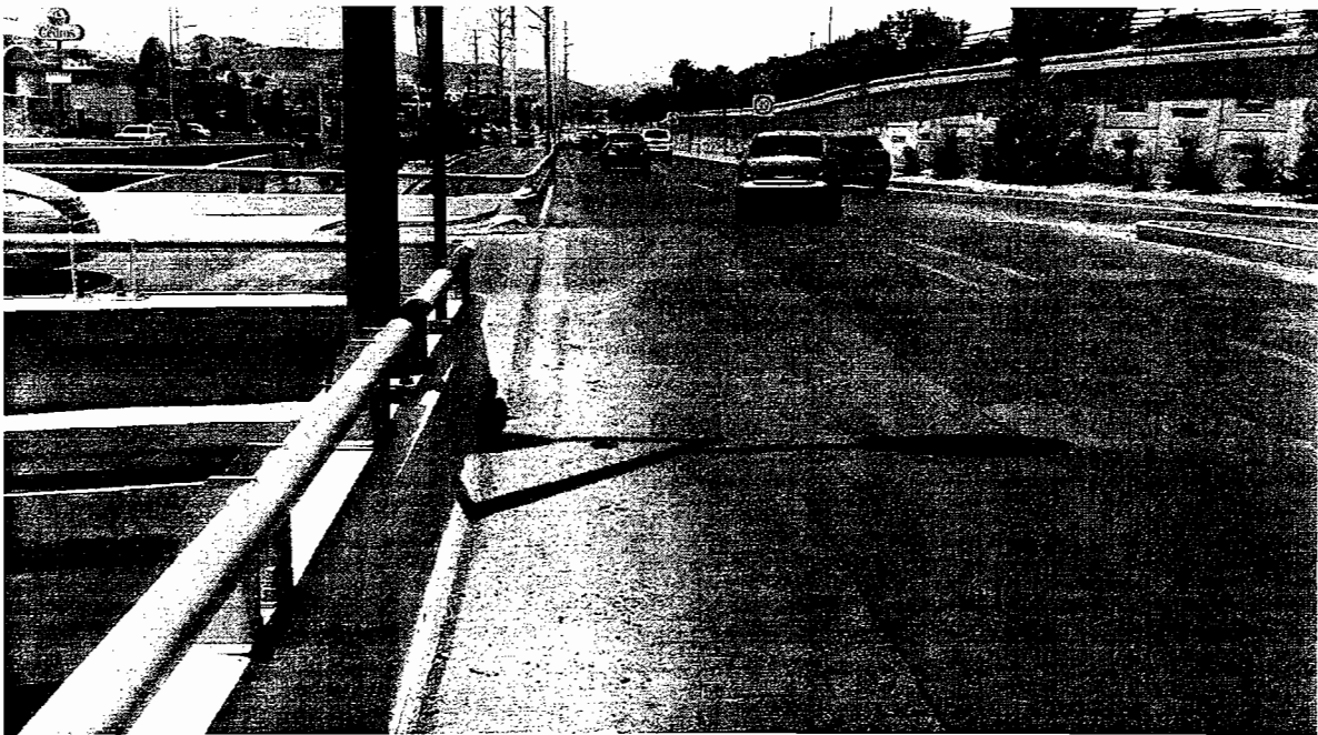
PINTURA EN PARAPETO QUE SE REINSTALO
