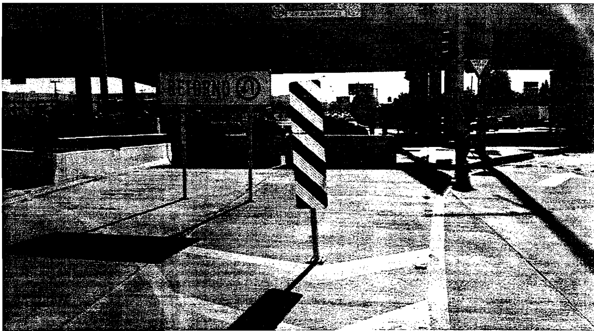
COLOCACION DE OD-5
