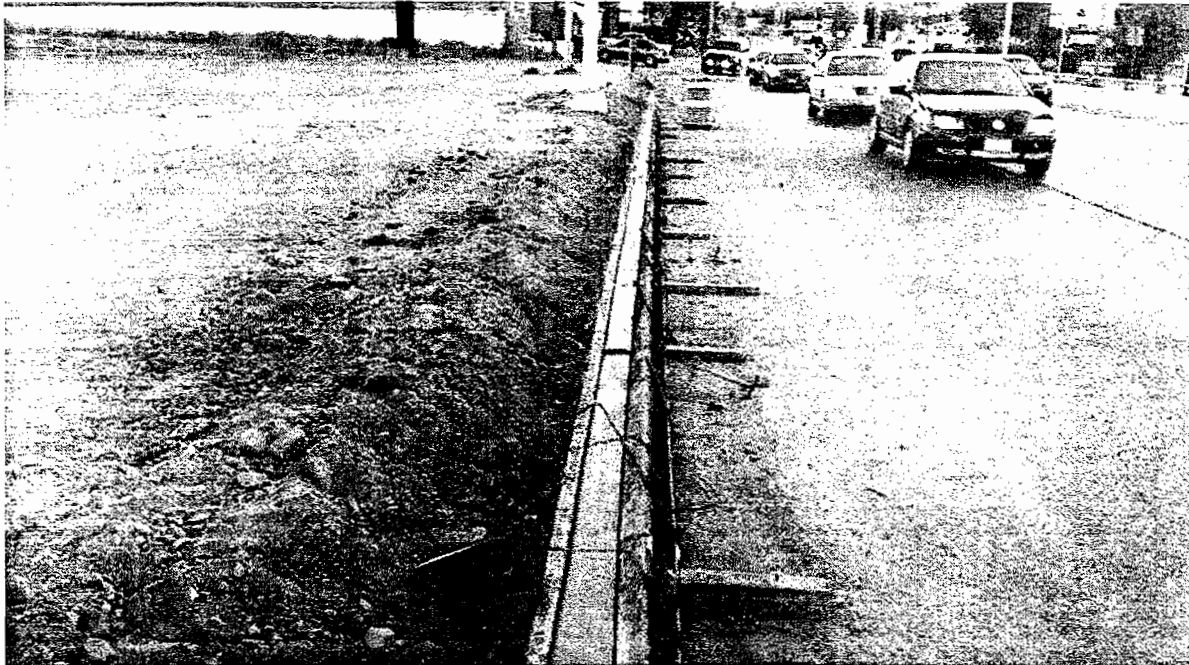
EXCAVACION PARA COLADO DE GUARNICION
