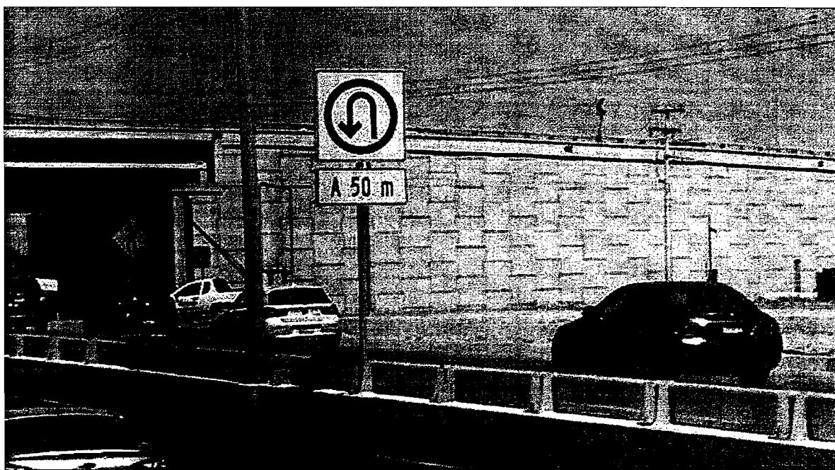
SEÑAL COLOCADA SOBRE PARAPETO METALICO CON TABLERO ADICIONAL A 50 M
