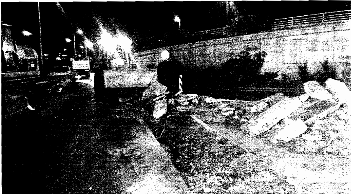
DEMOLICION DE CONCRETO SIMPLE
