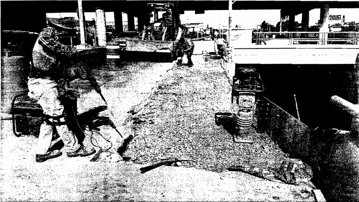
CORTE CON DISCO EN CONCRETO
