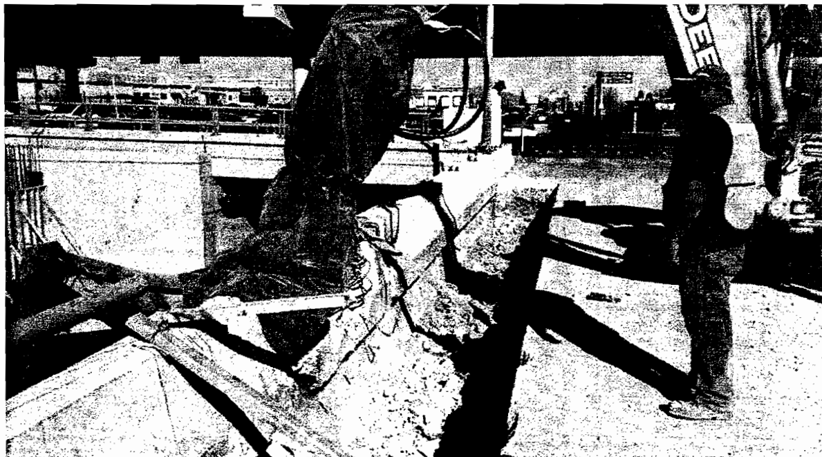
DEMOLICION DE CONCRETO ARMADO
