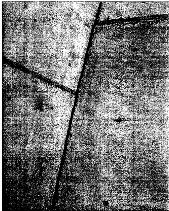
JUNTA DE DILATACION CARTON ASFALTADO
