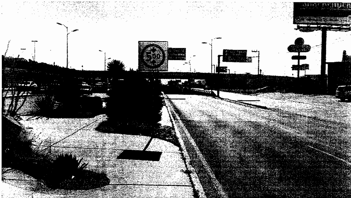
SEÑALAMIENTO DE ALTURA LIBRE
