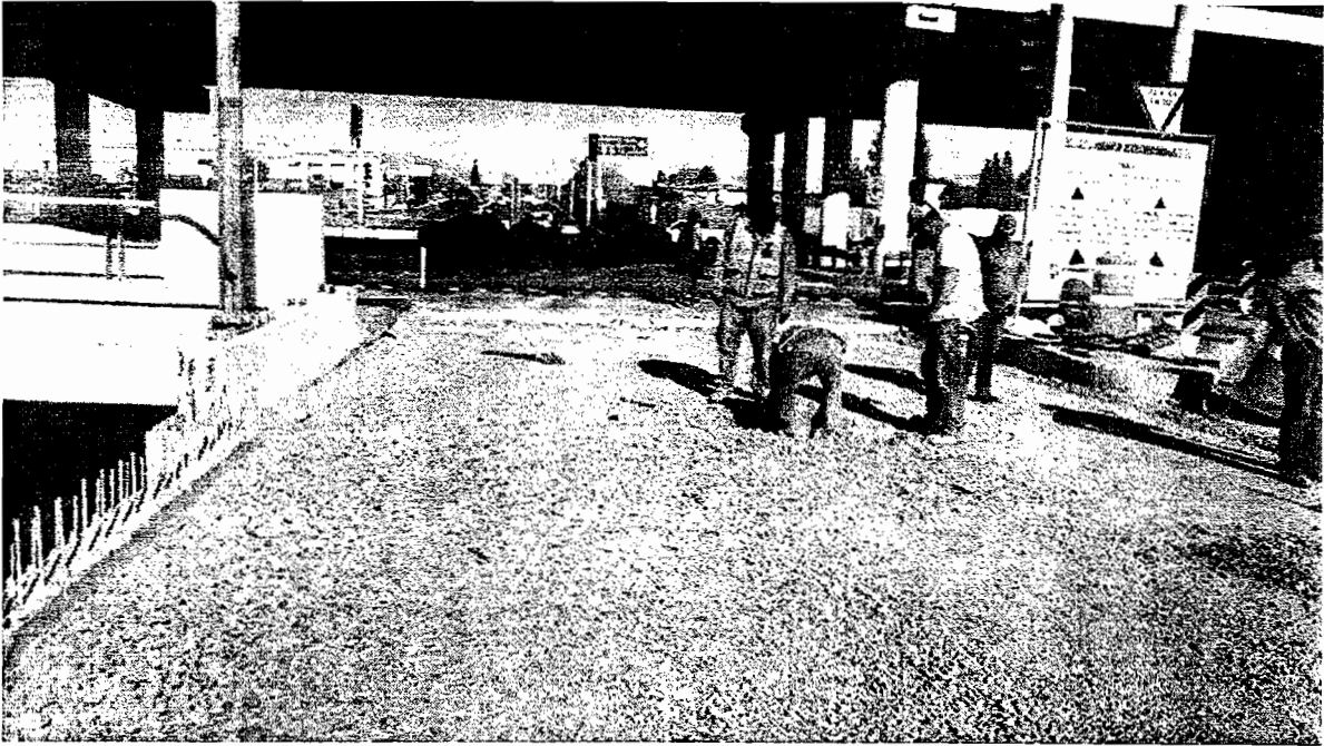
RELLENO EN LATERAL SUR
