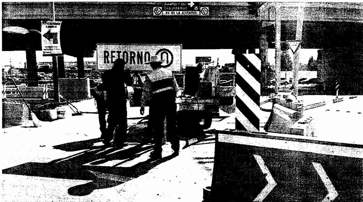
INSTALACION DE SEÑAL RETORNO DE 1.80 X .66
