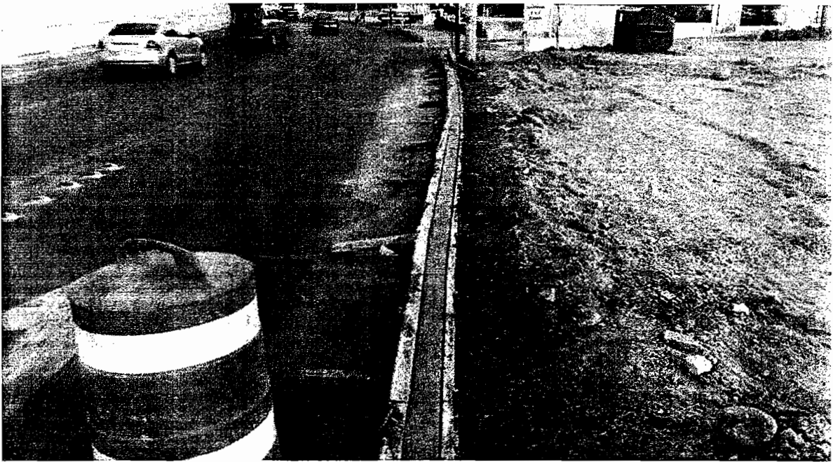
GUARNICIONES DE CONCRETO HIDRAULICO
