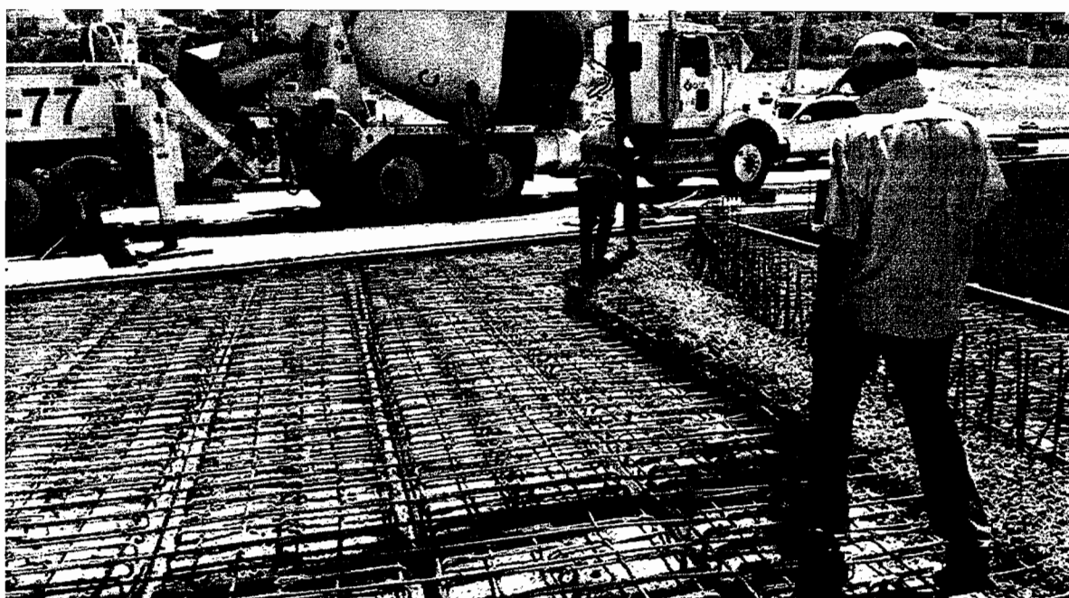
ACERO UTILIZADO EN TOPPING
