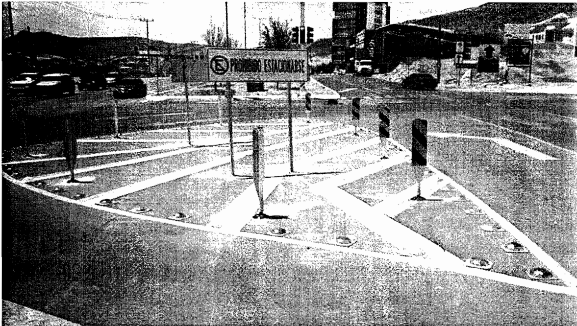
Suministro e instalación de poste abatible y señal de 56 x 1.78 con la leyenda PROHIBIDO ESTACIONARSE
