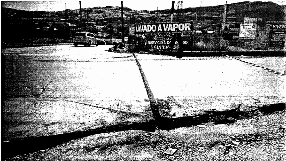
Canalización en terracerías y asfalto y retiro de boyas
