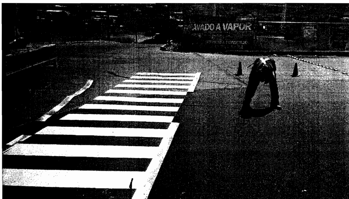
Recubrimiento en cruces peatonales y flechas
