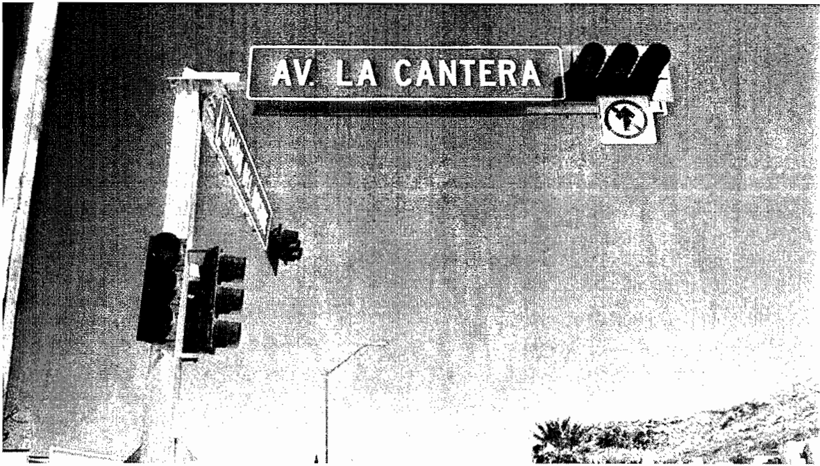
Instalación de señal SR de 61 x 61
