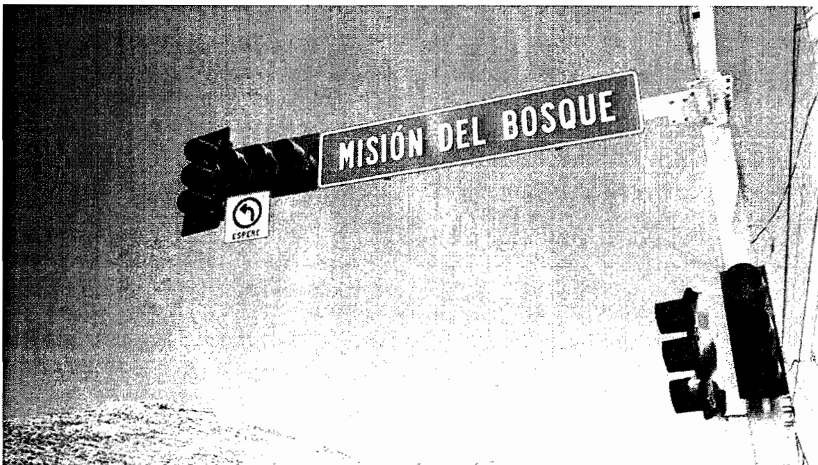
Suministro y colocación de estructura de PTR para habilitar semáforo
