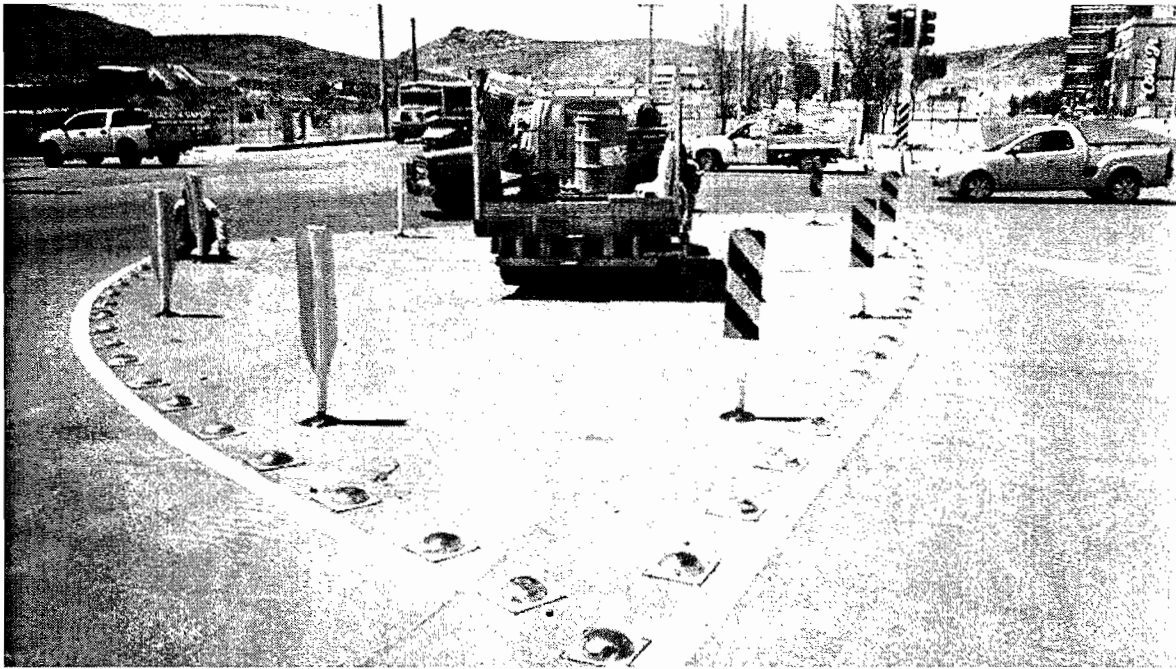
colocacion de boyas
