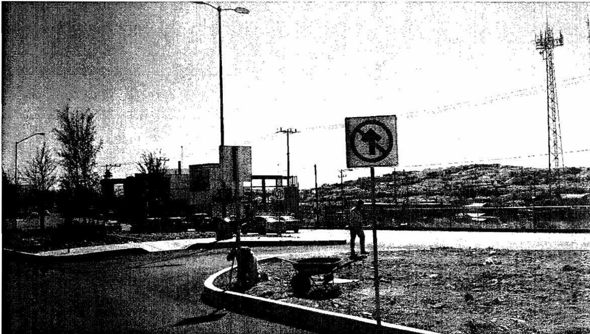
Suministro y colocación de señales restrictivas
