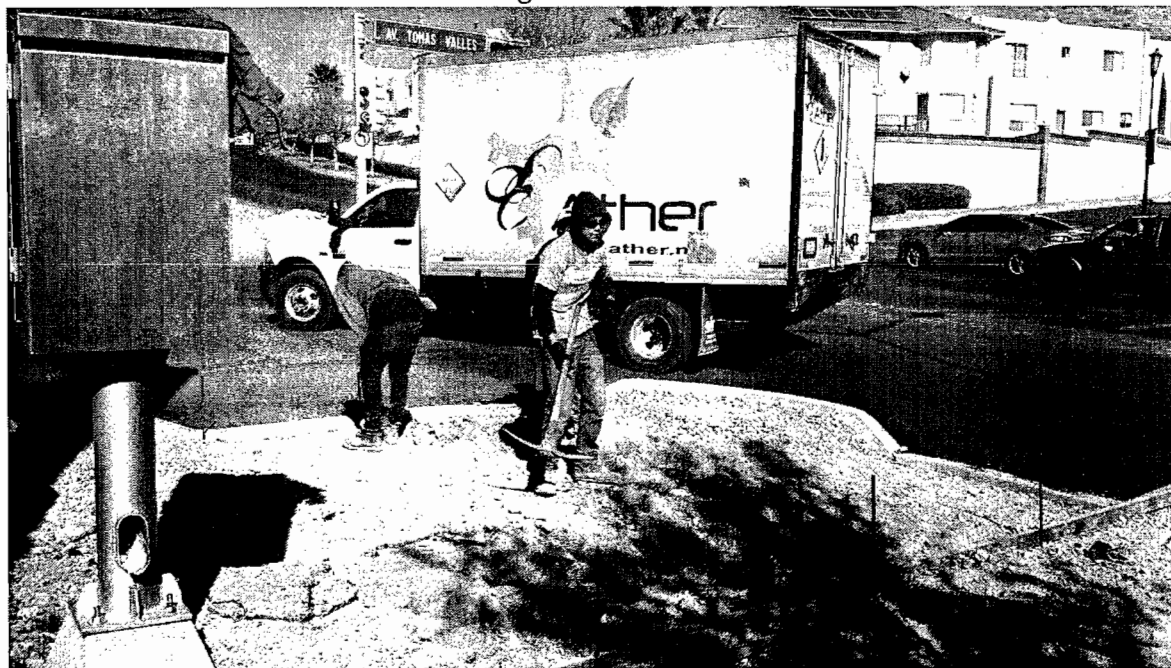
Suministro y colocación de control 170 – E
