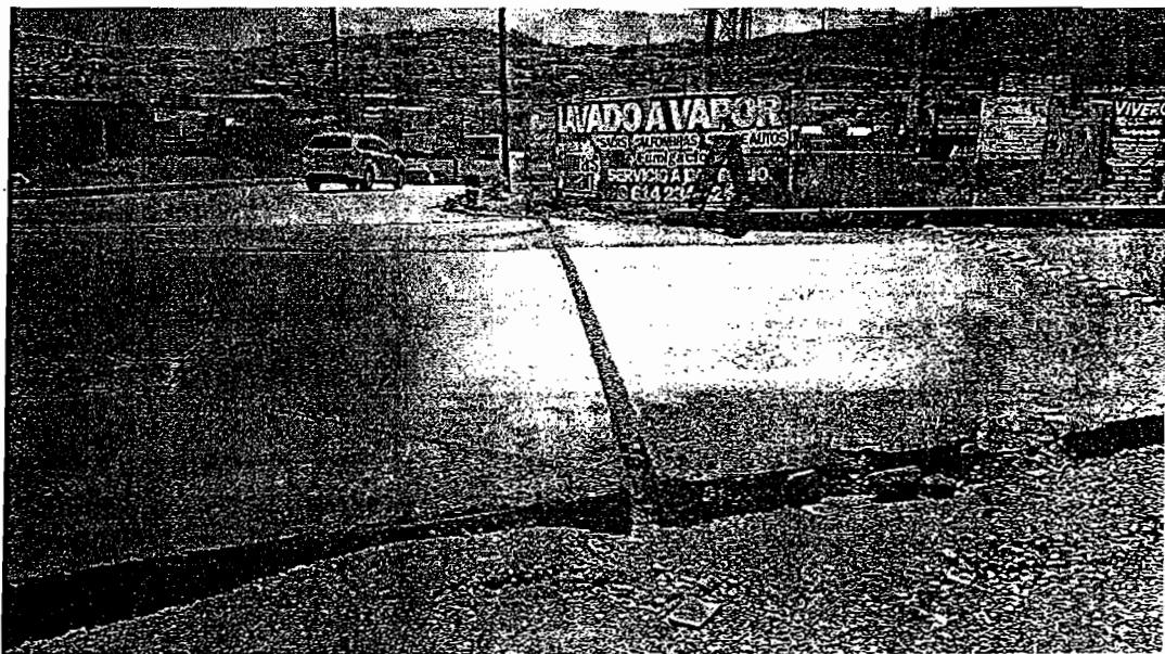
CANALIZACION DE CABLE
