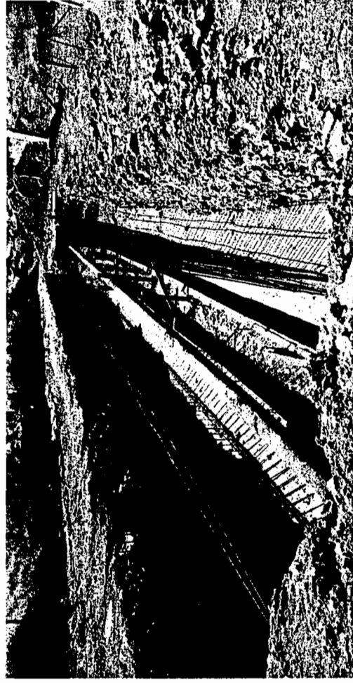
PLANTILLA DE CONCRETO DE 5 CM DE ESPESOR
