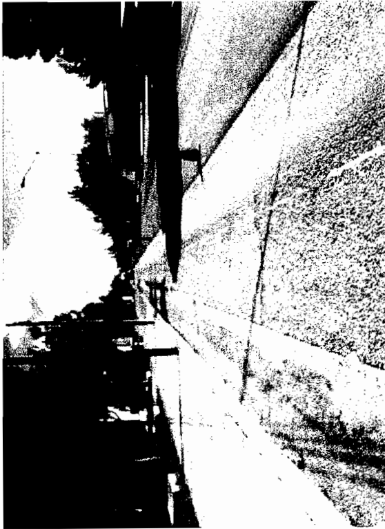
APLICACIÓN DE MICROCARPETA DE 1.00 CM DE ESPESOR
