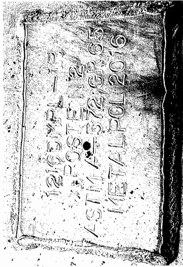
PLACAS DE IDENTIFICACION DE POSTES TRONCOCONICOS INSTALADOS
