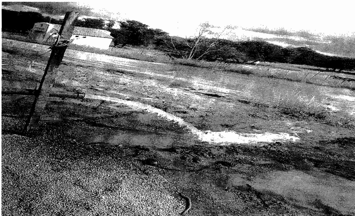
DESARROLLO Y AFORO DE POZO CON BOMBA TIPO TURBINA.
