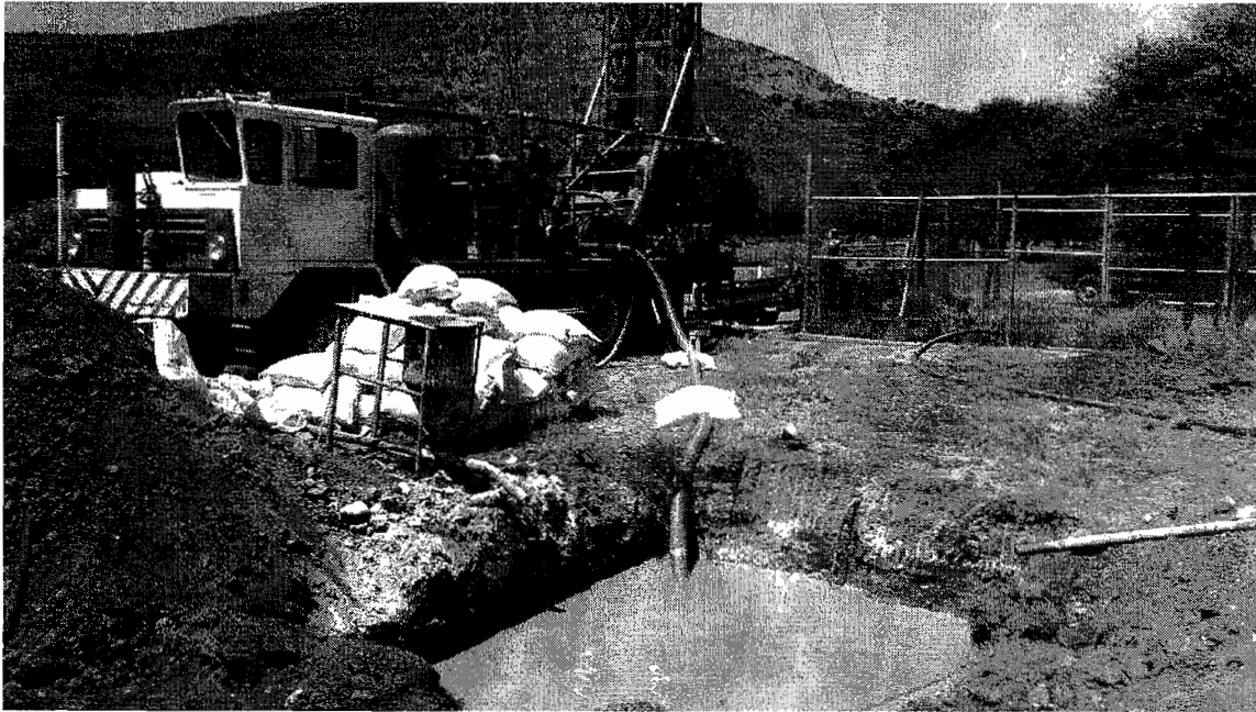
LODOS DE PERFORACION.
