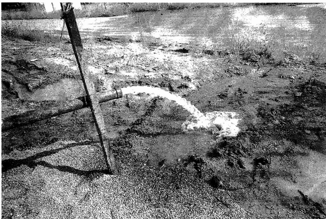
DESARROLLO Y AFORO DE POZO CON BOMBA TIPO TURBINA.
