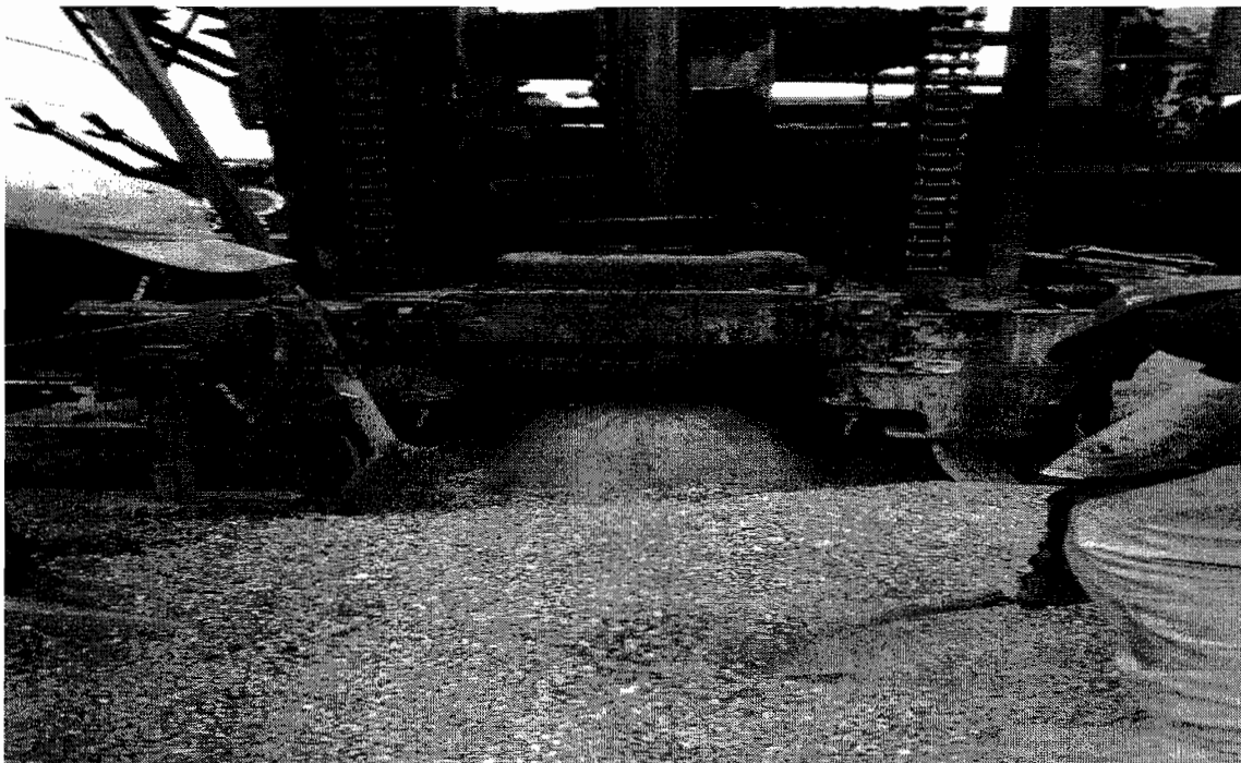
SUMINISTRO Y COLOCACIÓN DE GRAVA FILTRO PARA POZO
