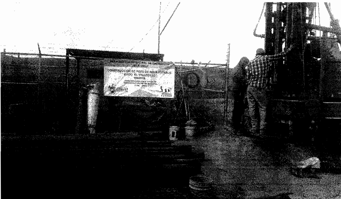
PERFORACION EXPLORATORIA A 12" DE DIAMETRO
