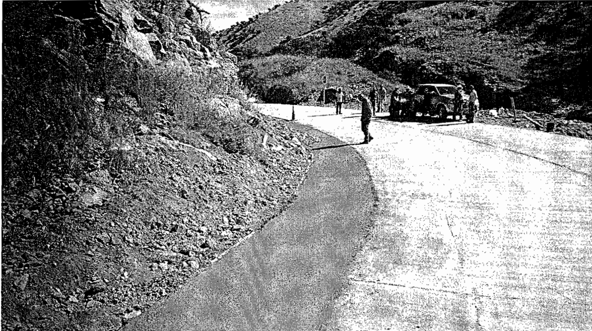
FABRICADO Y COLOCADO DE CONCRETO DE F'C=200 KG/CM2
