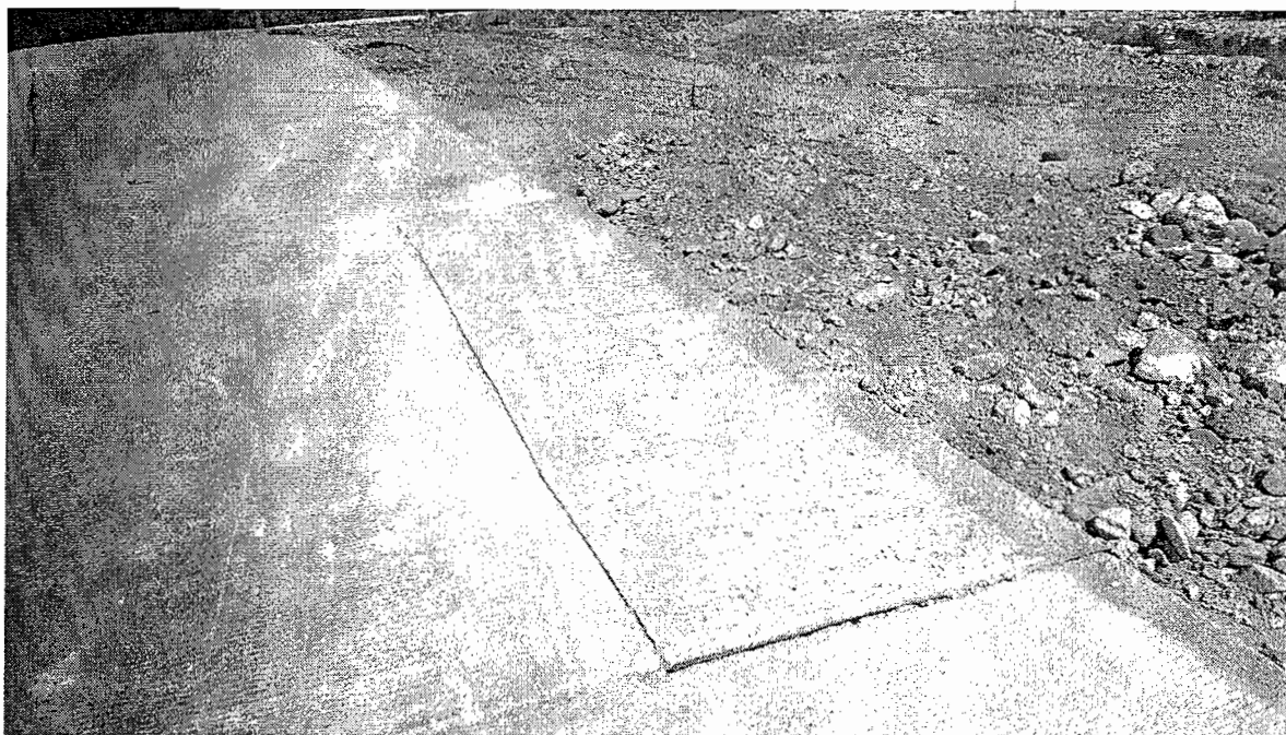
FABRICADO Y COLOCADO DE CONCRETO DE F'C=250 \text{ KG/CM}^2
