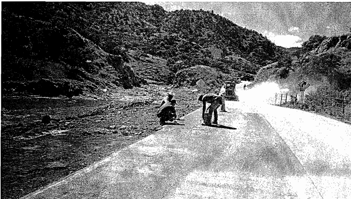
FABRICADO Y COLOCADO DE CONCRETO DE F'C=250 KG/CM 2
