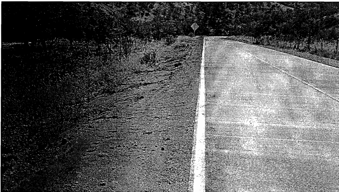
SUMINISTRO DE BASE HIDRAULICA
