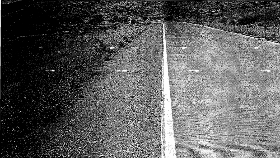
SUMINISTRO DE BASE HIDRAULICA
