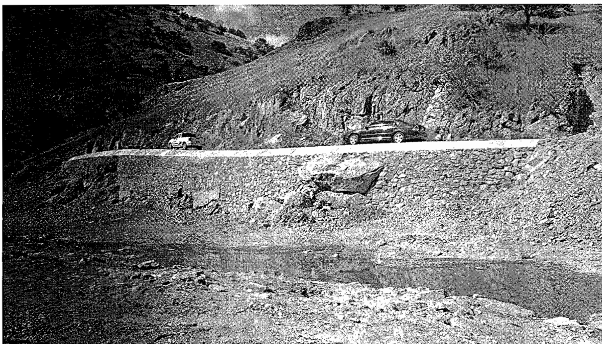
MURO DE MAMPOSTERIA
