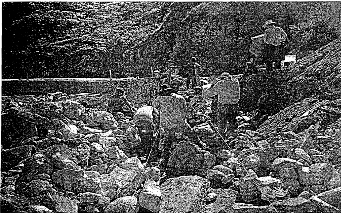
CONSTRUCCION DE MURO DE MAMPOSTERIA
