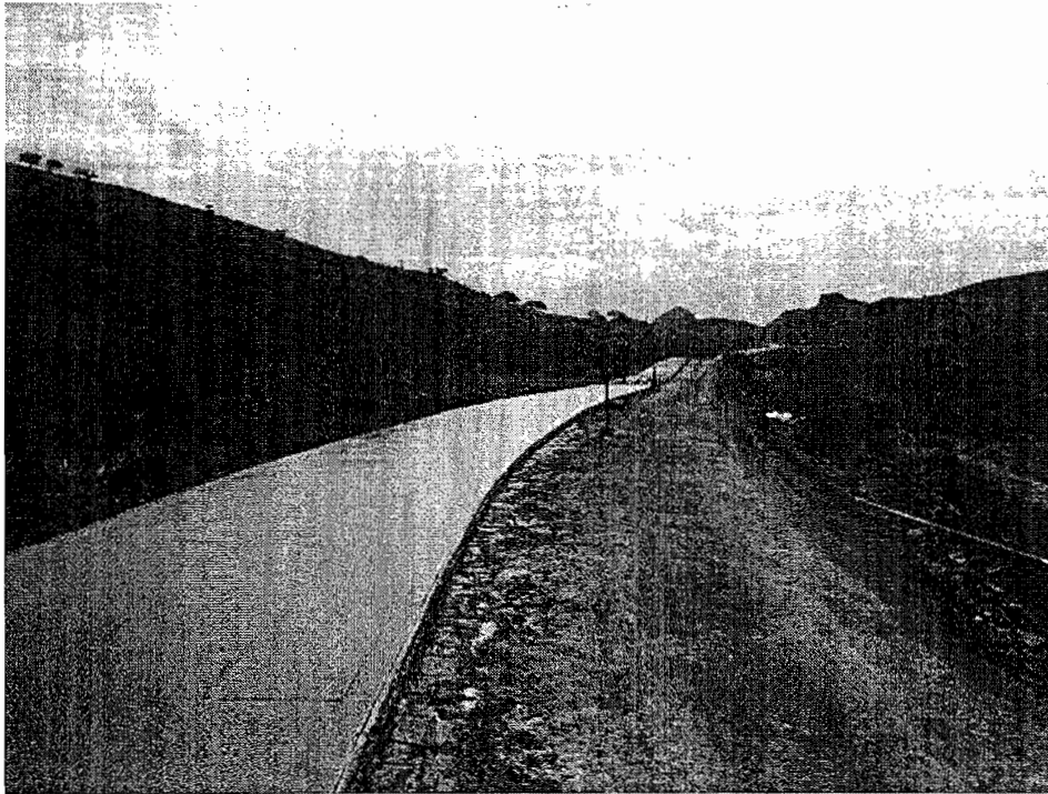
CARPETA DE CONCRETO HIDRAULICO
