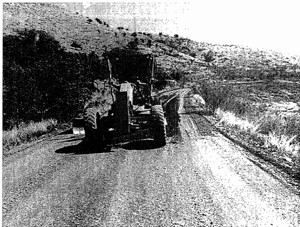
TRATAMIENTO DE MATERIAL DE BASE
