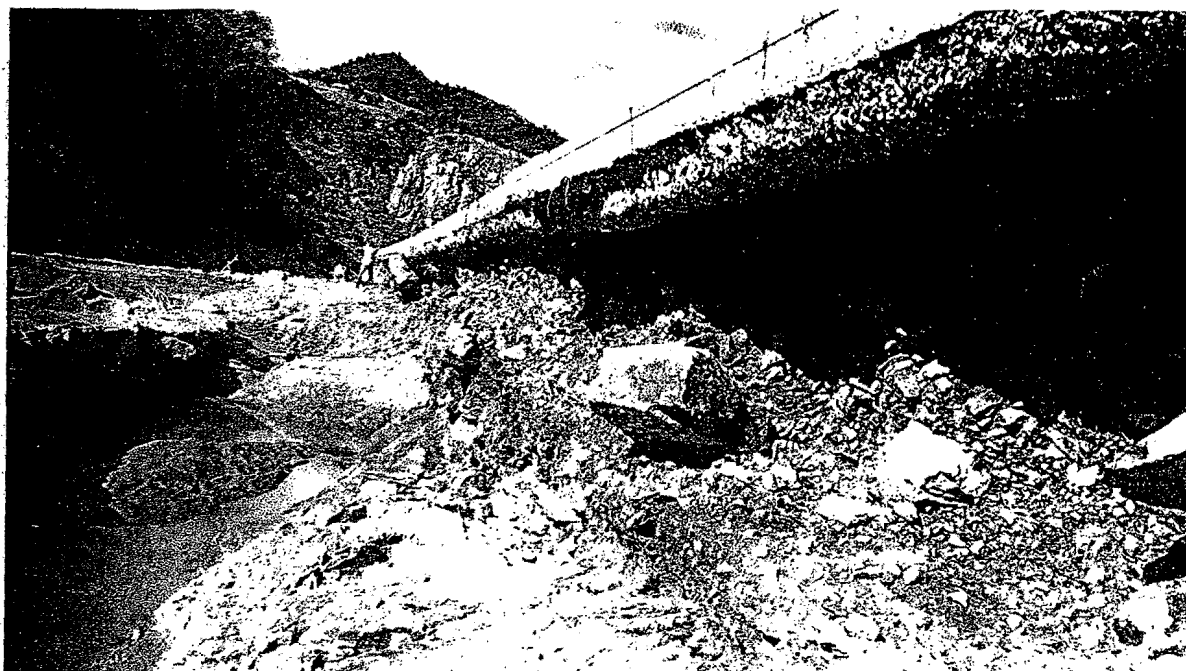
SOCAVACION EN EL TRAMO 21+830 AL 21+ 960
