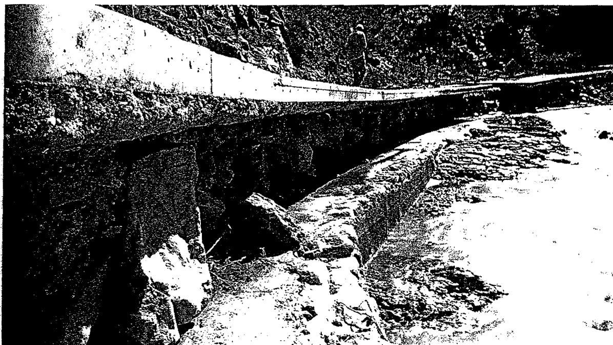
SOCAVACION EN EL TRAMO 21+830 AL 21+ 960
