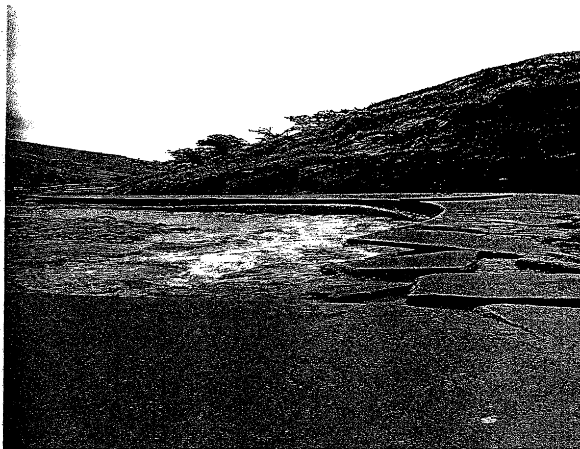
RUPTURA Y MOVIMIENTO DE CONCRETO DE CONCRETO DEL KM 21+948 AL 21+ 960
