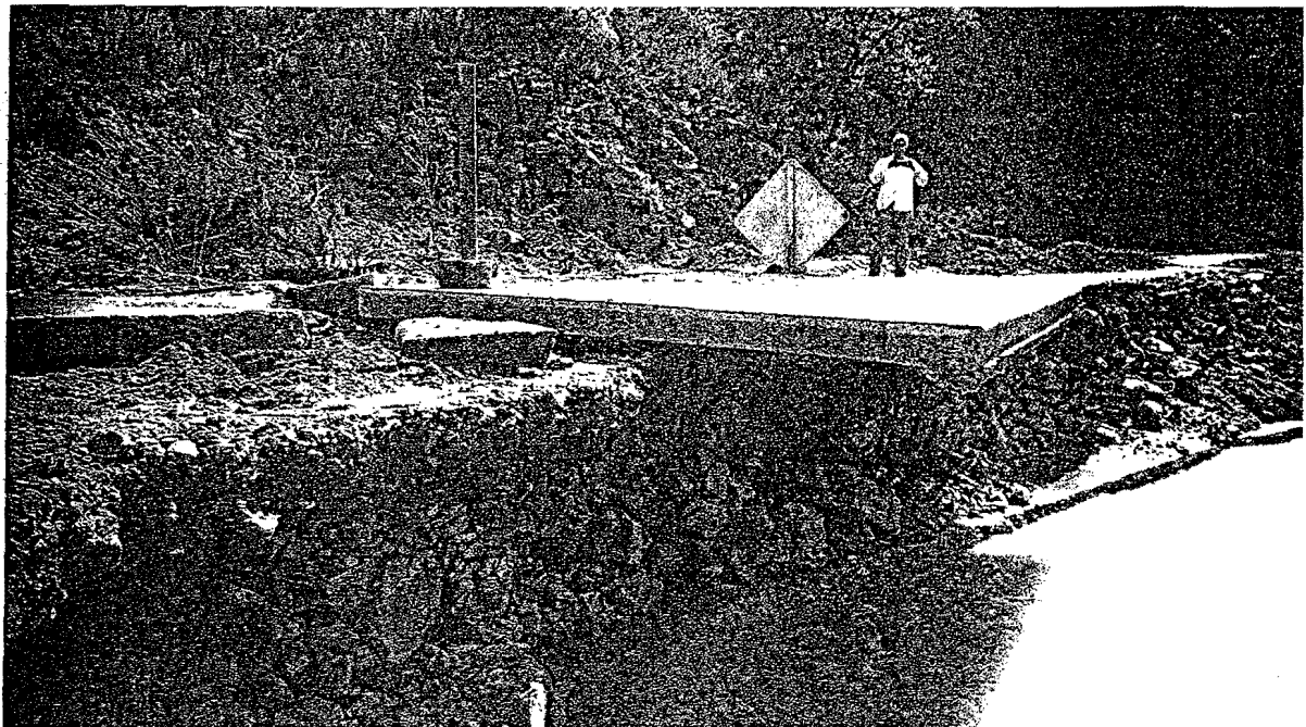
RUPTURA Y MOVIMIENTO DE CONCRETO DE CONCRETO DEL KM 21+948 AL 21+ 960
