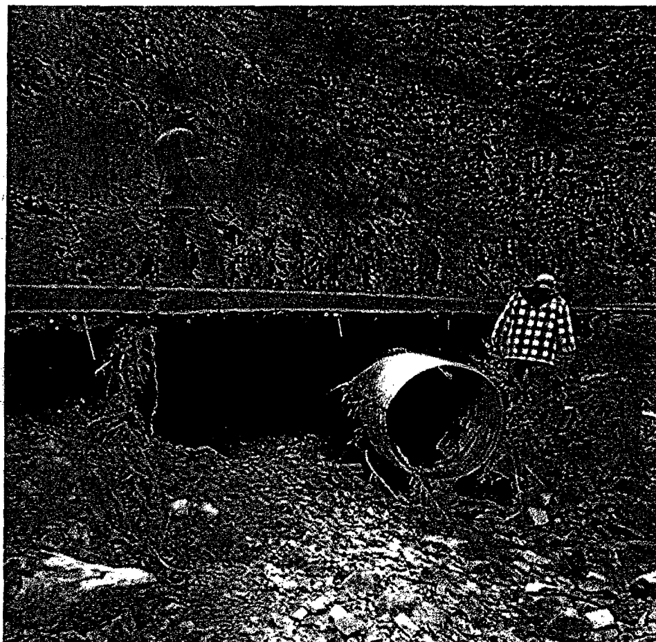
OBRA DE DRENAJE UBICADA EN EL KM 21 + 850
