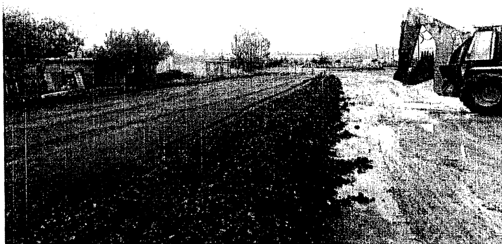
Calle Morelia (lado Sur) --- 0+058 al 0+013
