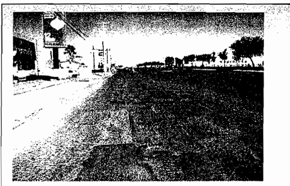
PAVIMENTO CON GRIETAS, BACHES, DEFORMACIONES Y DESGASTE DE SUPERFICIE EN AV. COLÓN
