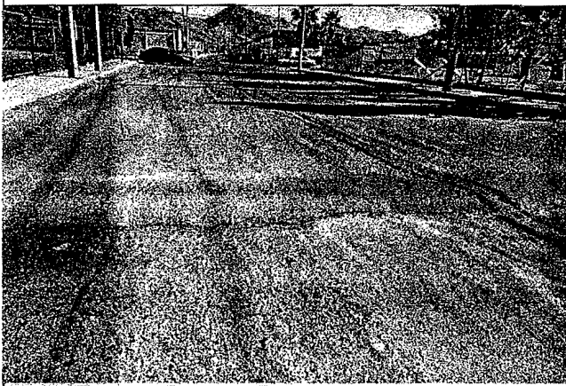
PAVIMENTO CON GRIETAS, BACHES, DEFORMACIONES Y DESGASTE DE SUPERFICIE
