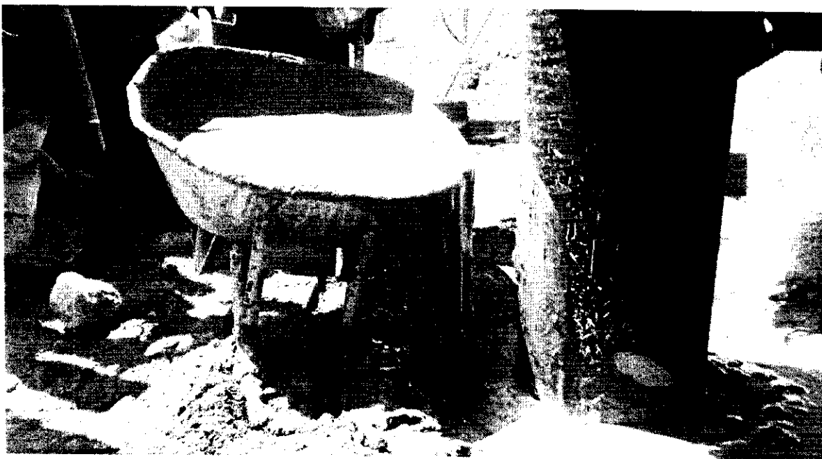
CEMENTACION PARA PROTECCION SANITARIA
