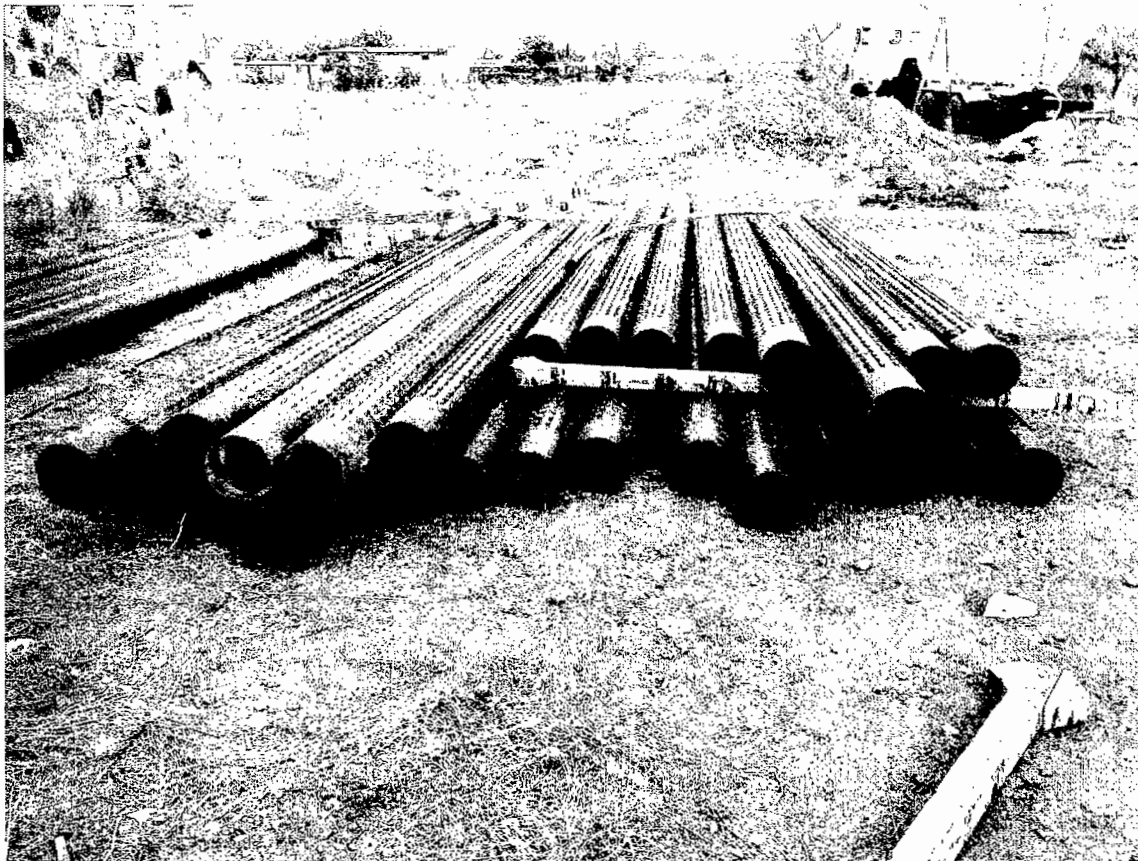
SUMINISTRO DE TUBO 8" X 1/4 ACERO LISO Y RANURADA NORMAL TIPO CANASTILLA.
