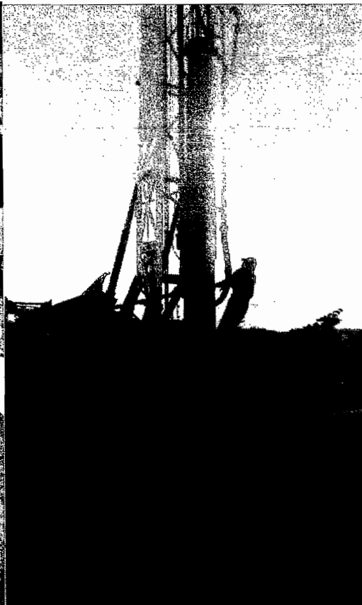
COLOCACION DE TUBERIA DE ADEME DE 14" DE DIAMETRO PARA CONTRA ADEME
