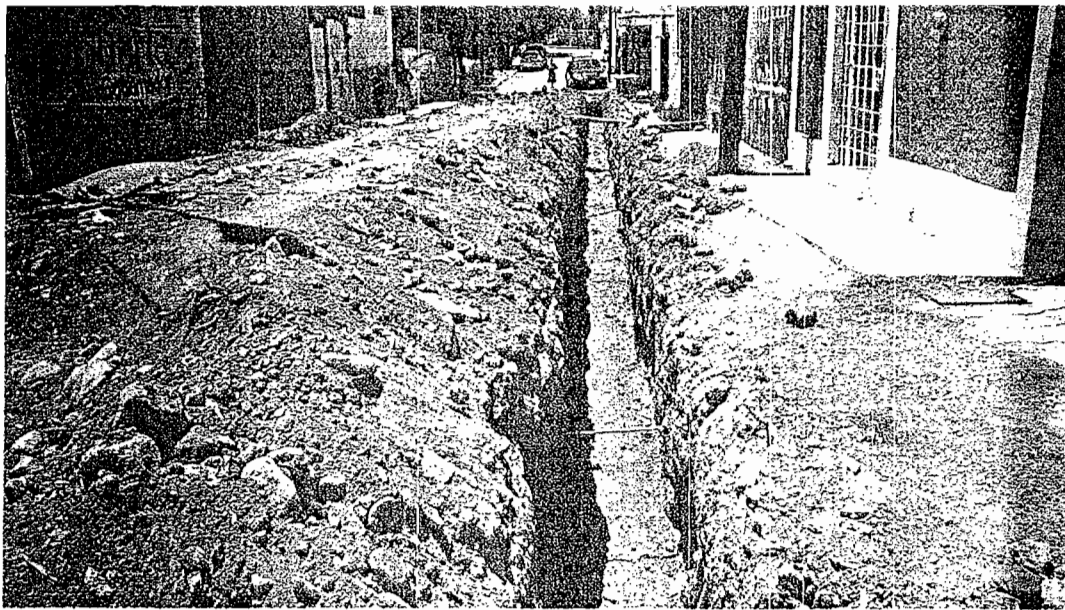
EXCAVACION EN MATERIAL TIPO B PROFUNDIDAD HASTA 2.00 M CON MAQUINA INCLUYE ACARREO A UN PUNTO EN OBRA:
