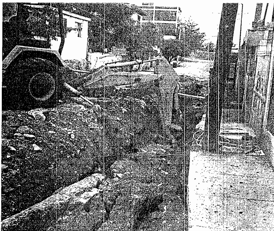
EXCAVACION EN MATERIAL TIPO B PROFUNDIDAD HASTA 2.00 M CON MAQUINA INCLUYE ACARREO A UN PUNTO EN OBRA:
