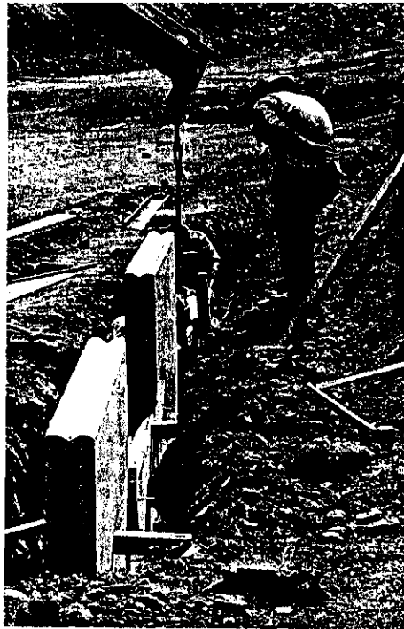
1.- Excavaciones para dala de desplante de muros mecanicamente estabilizados
