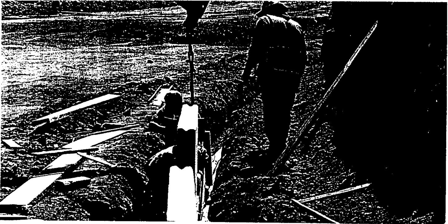
5.- Trabajos de colocacion de muros mediante grúa
