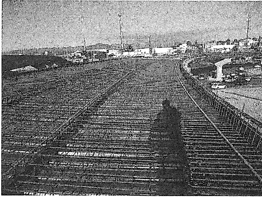
ACERO DE REFUERZO
