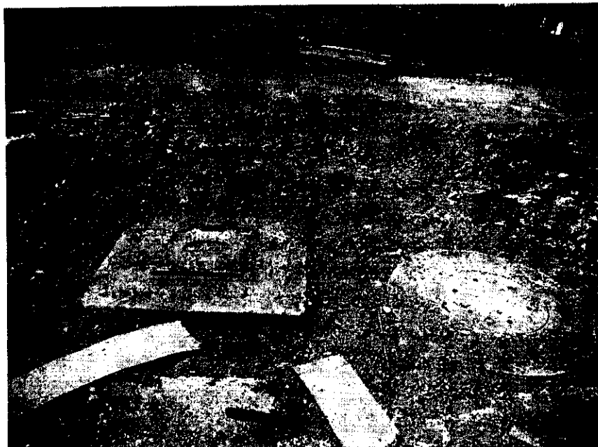
CAJA DE VALVULAS EN PILA 2
