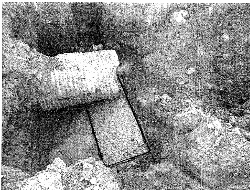
ZAPATA EN CABEZOTE DE TUBO
