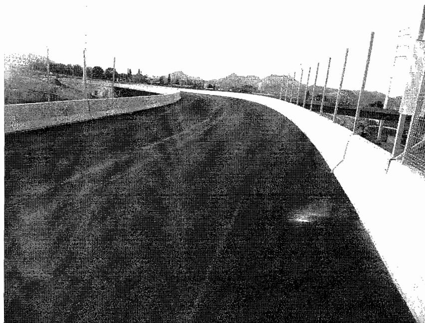
CARPETA DE 3 CM SOBRE LOSA DE PUENTE
